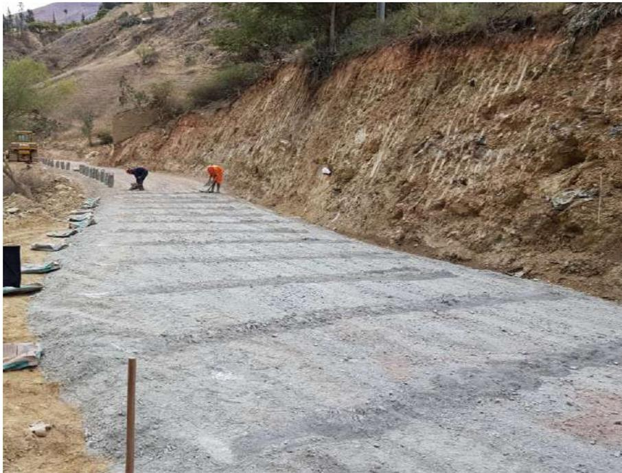
*Nota.* Estabilización de suelos a nivel de subrasante con cemento y aditivo Proes, tramo de prueba (2017). Fuente: Propia.
