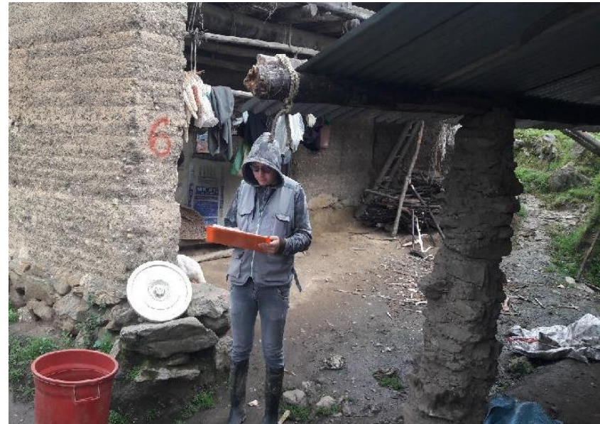
Fotografía 3. Vista de la fachada de la vivienda
