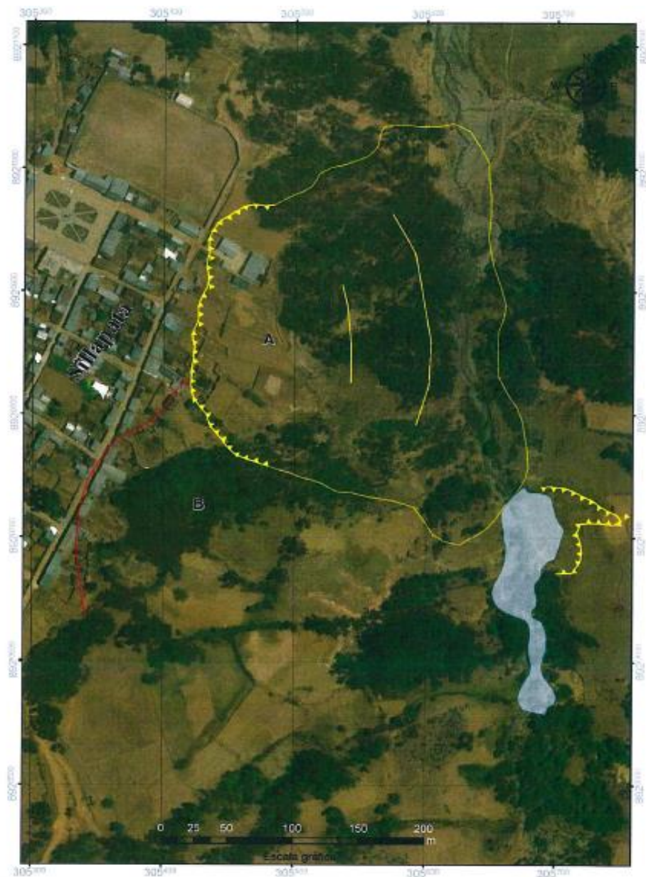
Figura 3. Se muestra el deslizamiento (A), con línea amarilla, deslizamiento (B) con línea roja; laguna formada por represamiento de color celeste. (Ortofoto fecha 01 de julio 2019)
