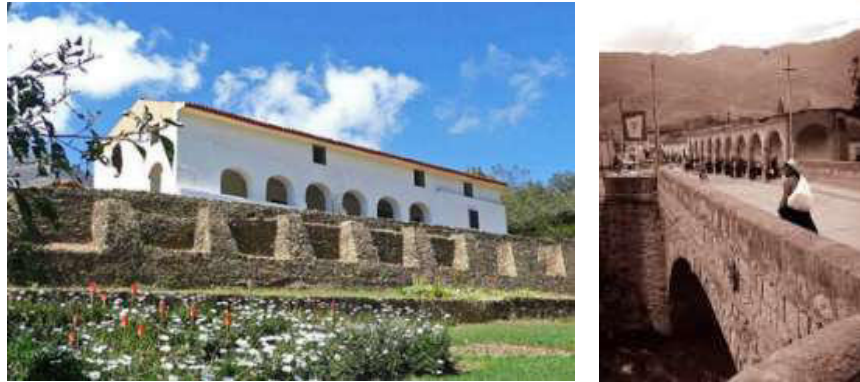
Figura 37 Casa Hacienda Shismay y Puente calicanto
