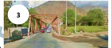
Acceso Puente Huallaga
