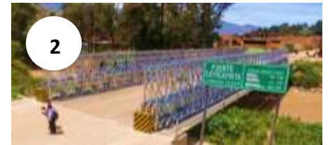
Acceso Puente Cayhuaynita
