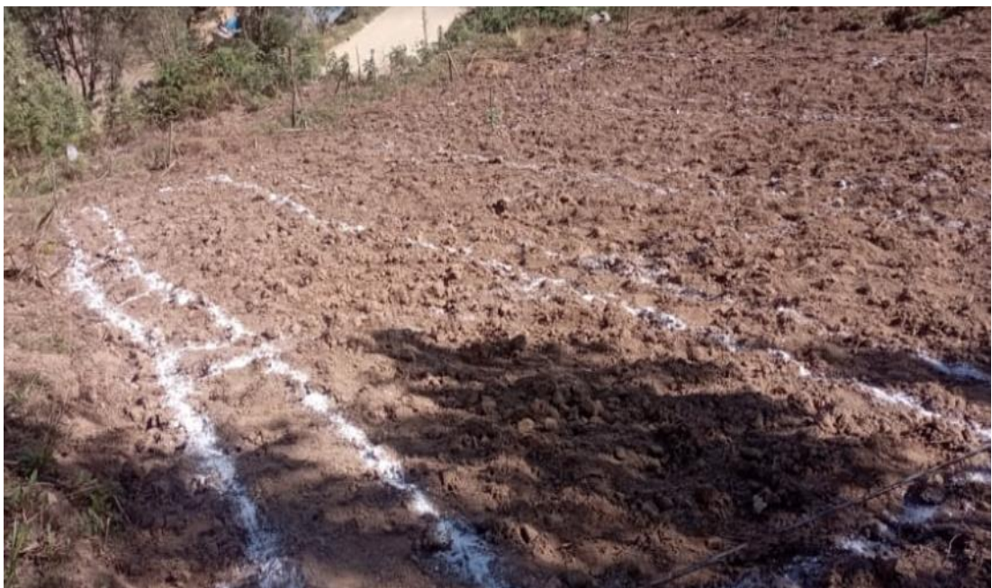
Foto 2: Preparación y delimitación del terreno.
