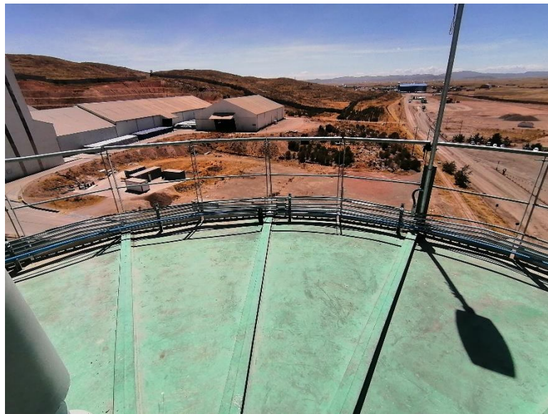
FOTO 8.- Vista superior Silo 800m3
