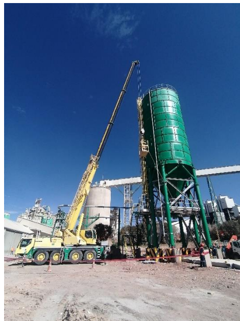
FOTO 2.- Montaje Silo Metálico 800m3
