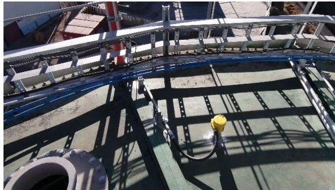
FOTO 12.- Switch nivel vibración varilla
