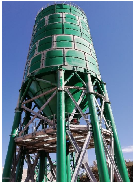
FOTO 1.- Estructura Silo Metálico 800m3
