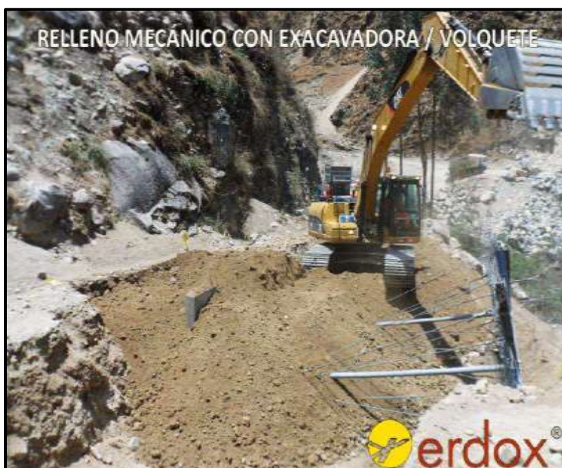
Fotografía 19. Relleno con material propio el sistema Erdox. (Fuente: Betonform)
