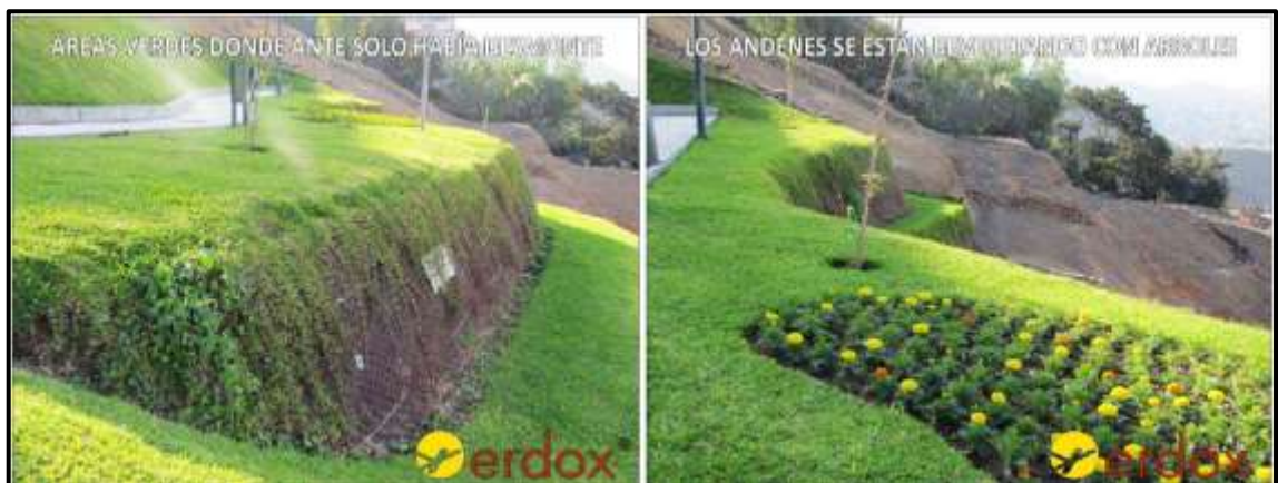
Fotografía 28. Taludes con Re-Vegetación de las Estructuras del Sistema ErdoX (Fuente: Betonform)
