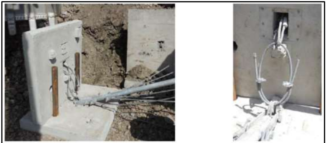
Fotografía 15. Conexión del tirante rígido a la placa de concreto. (Fuente: Betonform)
