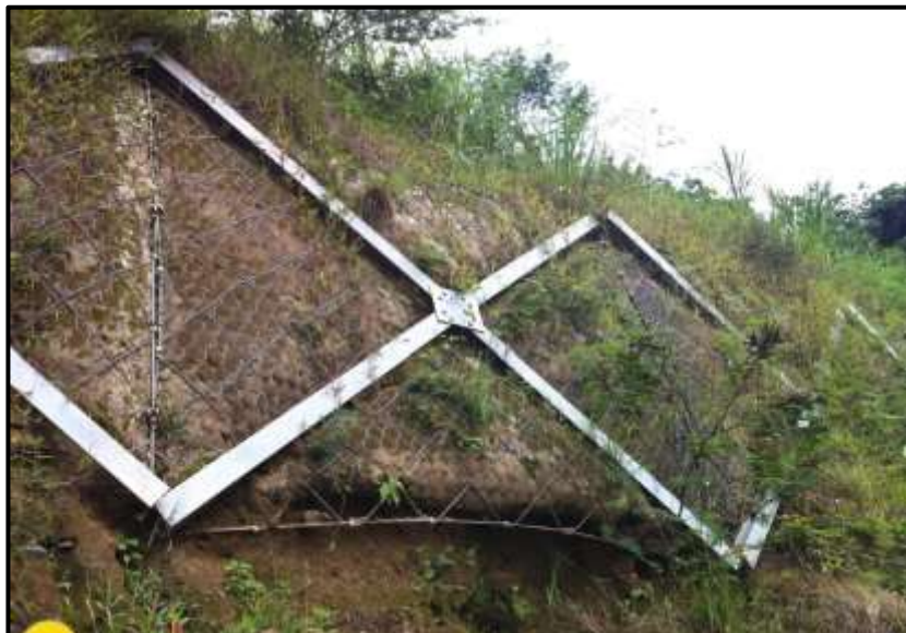
Fotografía 18. Unión de 02 paneles frontales del sistema ErdoX. (Fuente: Betonform)
