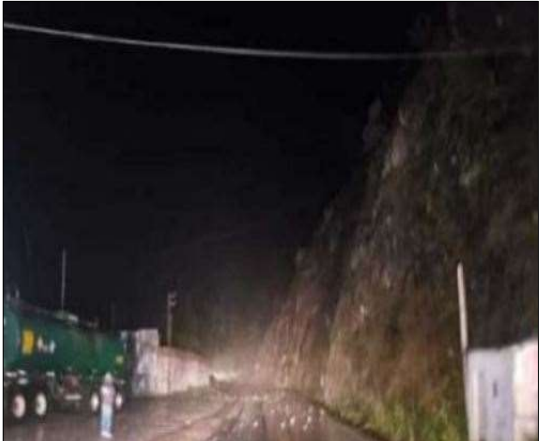
Fotografía 1. Deslizamiento de talud en la Carretera central Km 204. Fuente (Andina)
