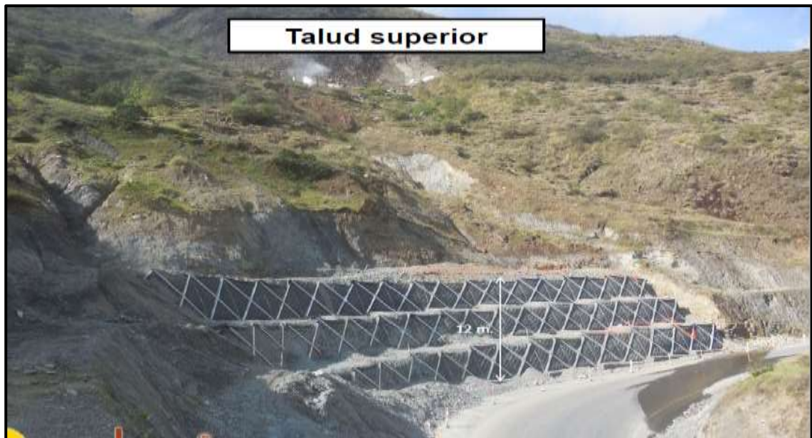
Fotografía 25. Talud superior a la carretera contenida con el Sistema ErdoX carretera IIRSA SUR - Km 127+850 (Fuente: Betonform)
