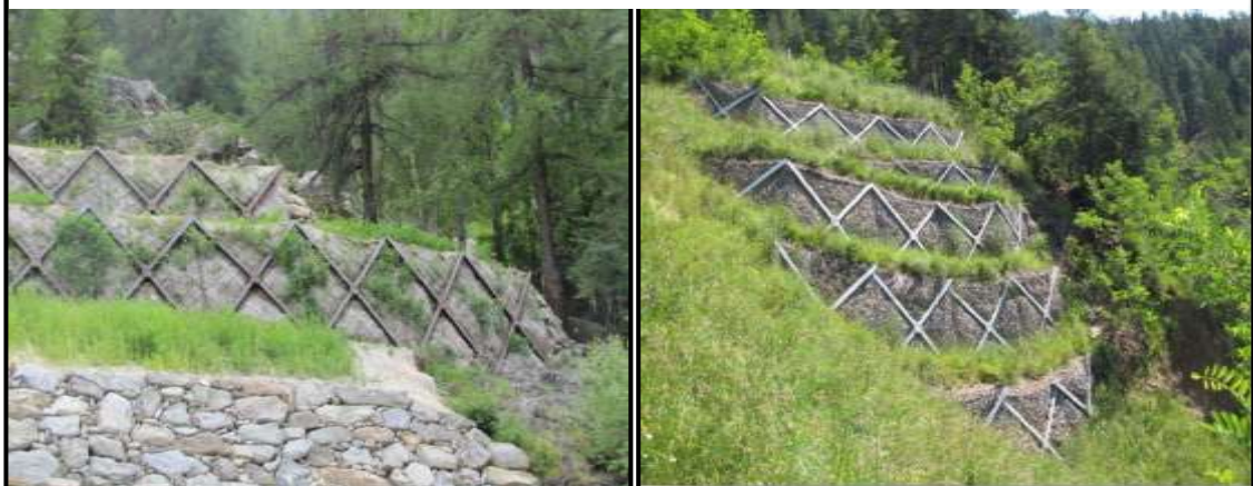
Fotografía 30. Taludes con Vegetación (Fuente: Betonform)
