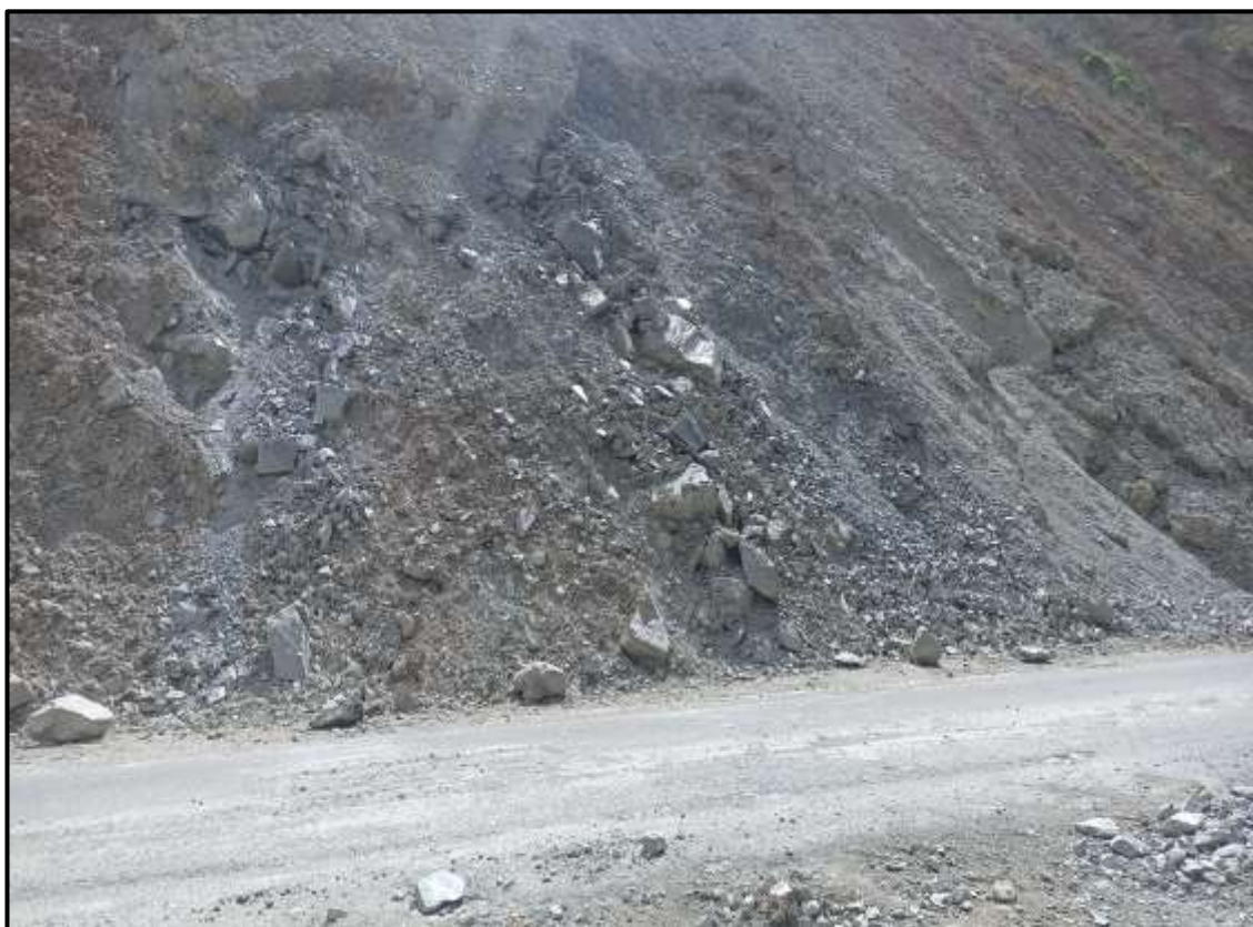
FOTOGRAFÍA N°2. Se observa el talud erosionado sin medidas de protección.
