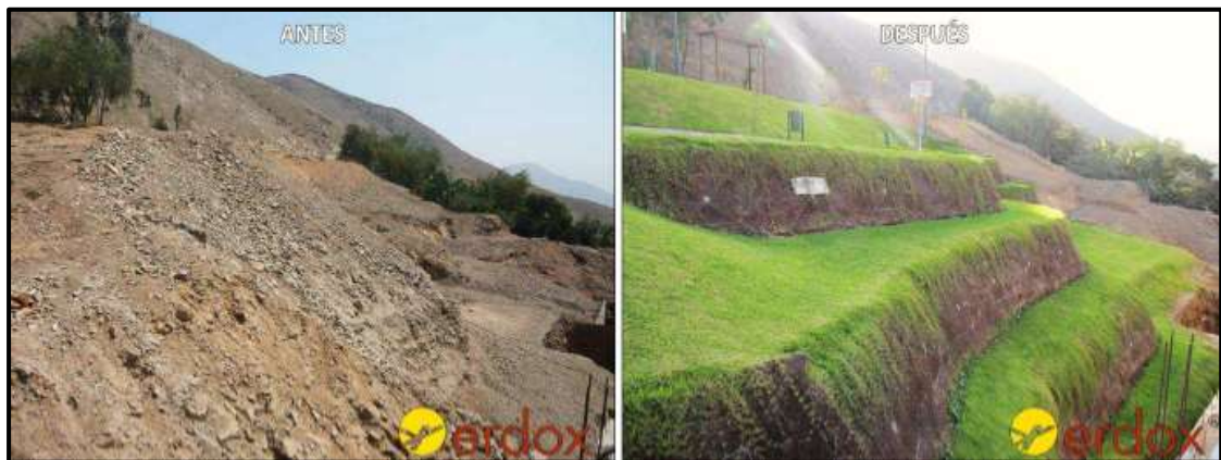
Fotografía 29. Taludes con Re-Vegetación de las Estructuras del Sistema ErdoX (Fuente: Betonform)
