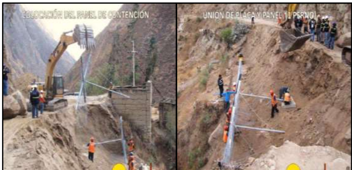
Fotografía 17. Traslado y colocación de la estructura ErdoX en su punto de Instalación. (Fuente: Betonform)
