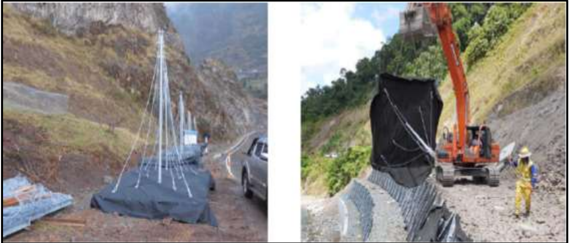
Fotografía 14. Traslado y colocación de la estructura Erdox en forma piramidal. (Fuente: Betonform)
