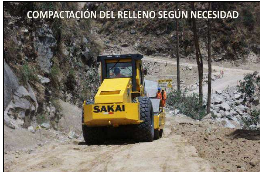
Fotografía 20. Compactación de las capas superiores después del relleno. (Fuente: Betonform)
