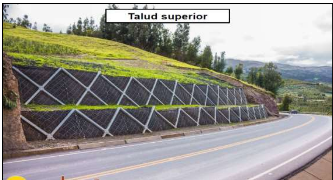
Fotografía 27. Talud Superior a la carretera Contenida con el Sistema ErdoX carretera IIRSA SUR – Km 000+500 (Fuente: Betonform)
