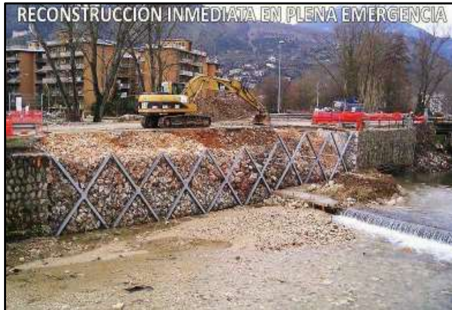
Fotografía 21. Sistema ErdoX en defensa ribereña - reconstrucción inmediata. (Fuente: Betonform)
