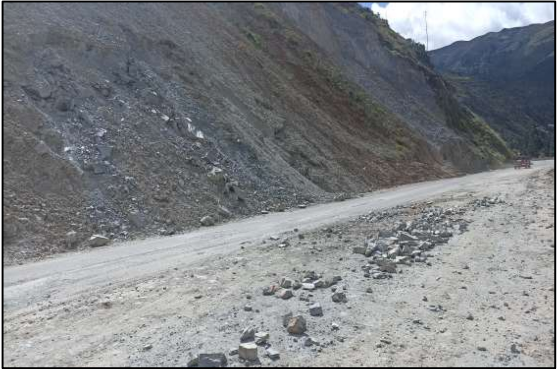
FOTOGRAFÍA N°3. Se observa se rocas en la carretera central Km 181+000 producto del deslizamiento.
