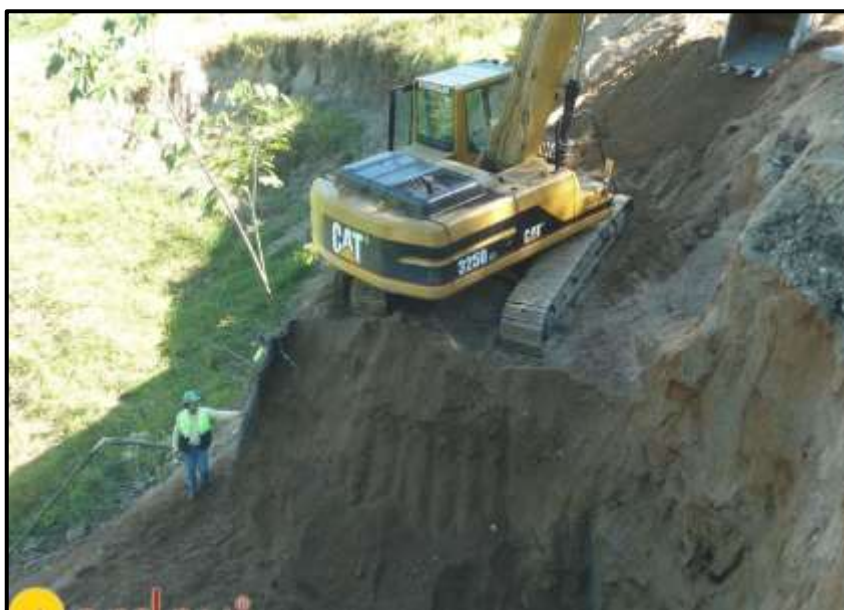
Fotografía 9. Excavación para la colocación del Erdox (Fuente: Betonform)
