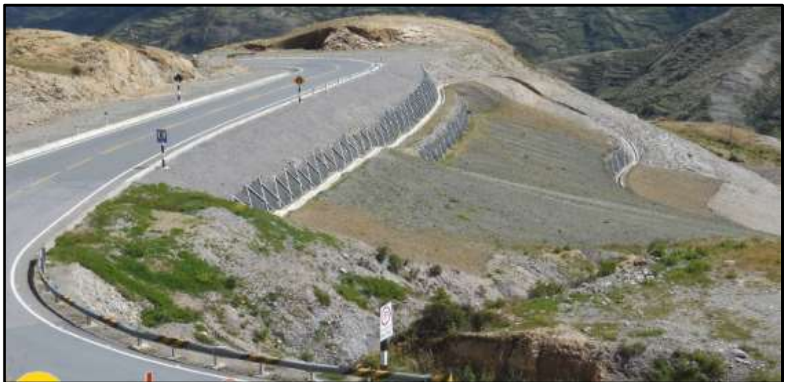
Fotografía 23. Talud inferior a la carretera contenida con el Sistema Erdox carretera IIRSA SUR - Km 11+750. (Fuente: Betonform)
