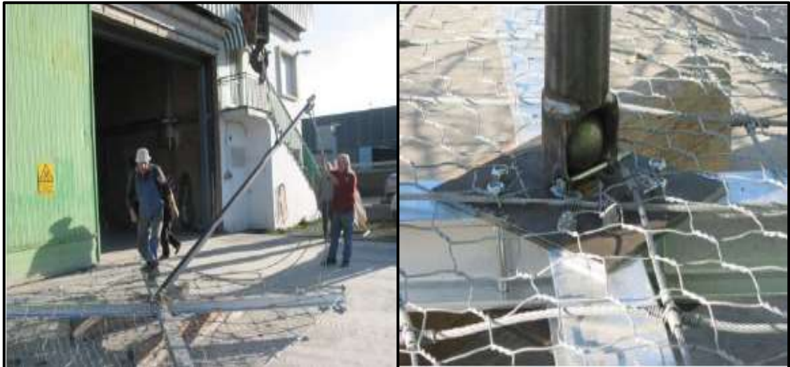
Fotografía 12. Abertura de vigas y colocación del tirante rígido. (Fuente: Betonform)
