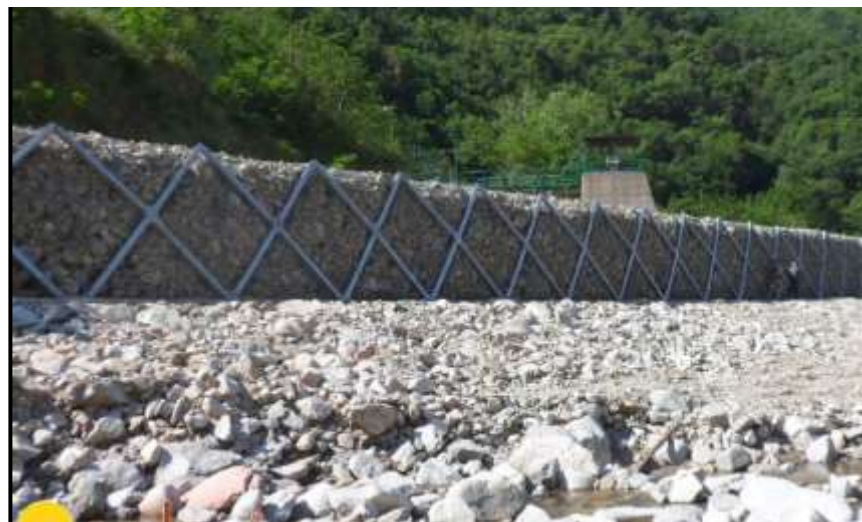
Fotografía 21. Sistema ErdoX en defensa ribereña - reconstrucción inmediata. (Fuente: Betonform)
