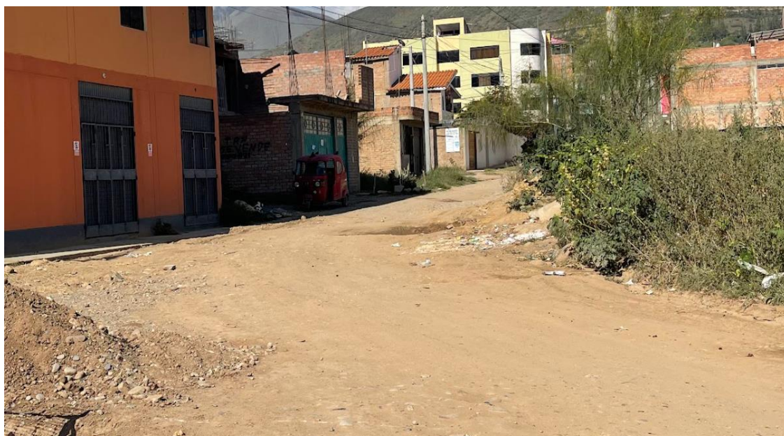
Imagen 2. Identificación de estación para conteo vehicular en el kilómetro 0+750.
