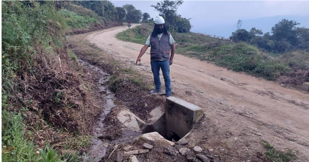
Foto 9. DESPUES: Se observa al jefe de mantenimiento en la actividad finalizada de limpieza de alcantarilla en la carretera en el km 5+639.
