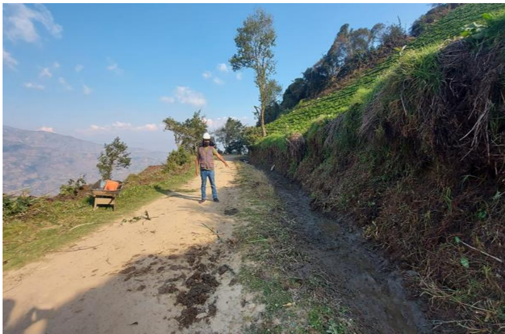
Foto 3. DESPUES: Se observa finalizado en la actividad de limpieza de cuneta en la carretera en el km 6+100- 6+240.
