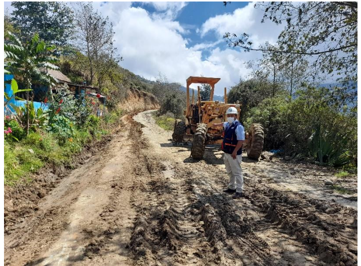
COMO SE PUEDE APRECIAR VERIFICANDO LOS TRABAJOS CONFORMANDO LA CUNETA EN EL CP. DE MAYOBAMBA ALTA (FOTO DURANTE).
