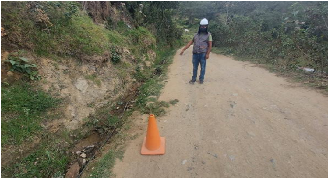
Foto 9. DESPUES: Se observa al jefe de mantenimiento en la actividad finalizada de limpieza de alcantarilla en la carretera en el km 5+639.
