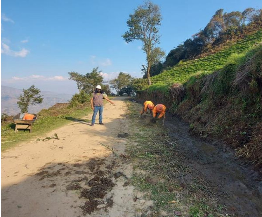
Foto 5. DURANTE: Se observa al jefe de mantenimiento en la ejecución de los trabajos de limpieza de calzada en la carretera del km 1+200 – 1+600.
