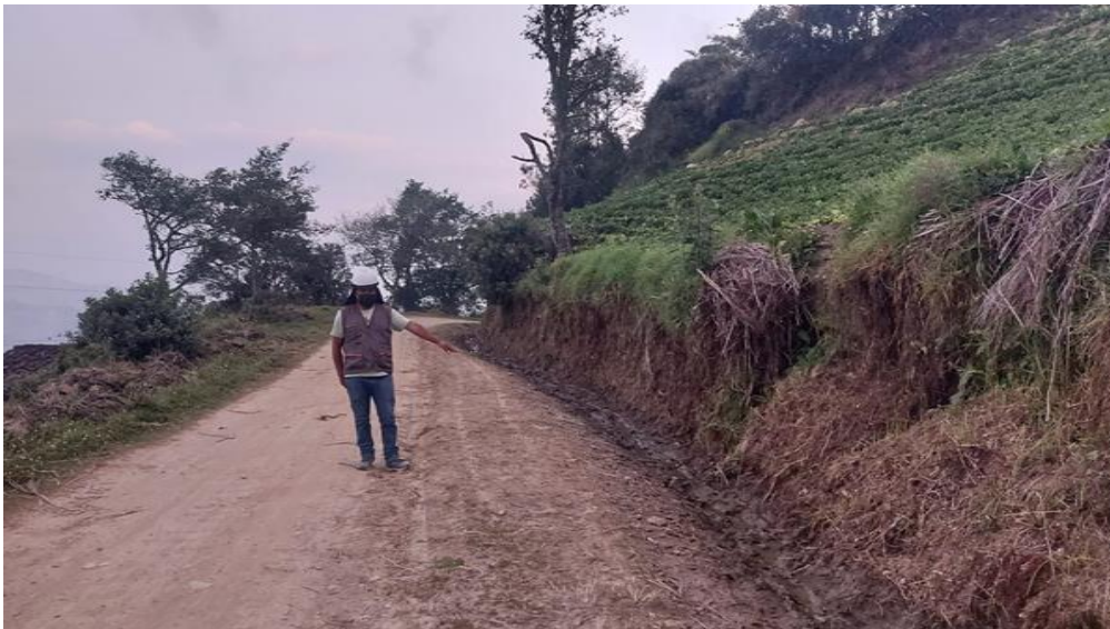
Foto 6. DESPUES: Se observa finalizado los trabajos de limpieza de calzada en la carretera en el km 1+200 – 1+600.
