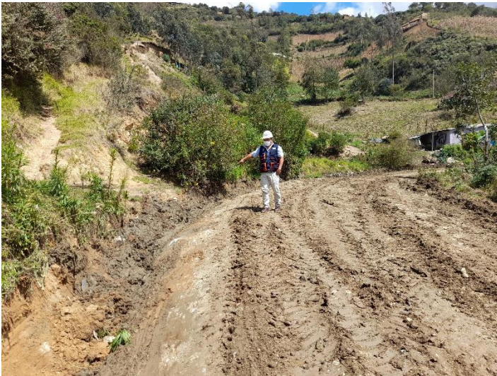
COMO SE PUEDE APRECIAR VERIFICANDO LOS TRABAJOS CONFORMANDO LA CUNETA EN EL CP. DE MAYOBAMBA ALTA (FOTO DURANTE).
