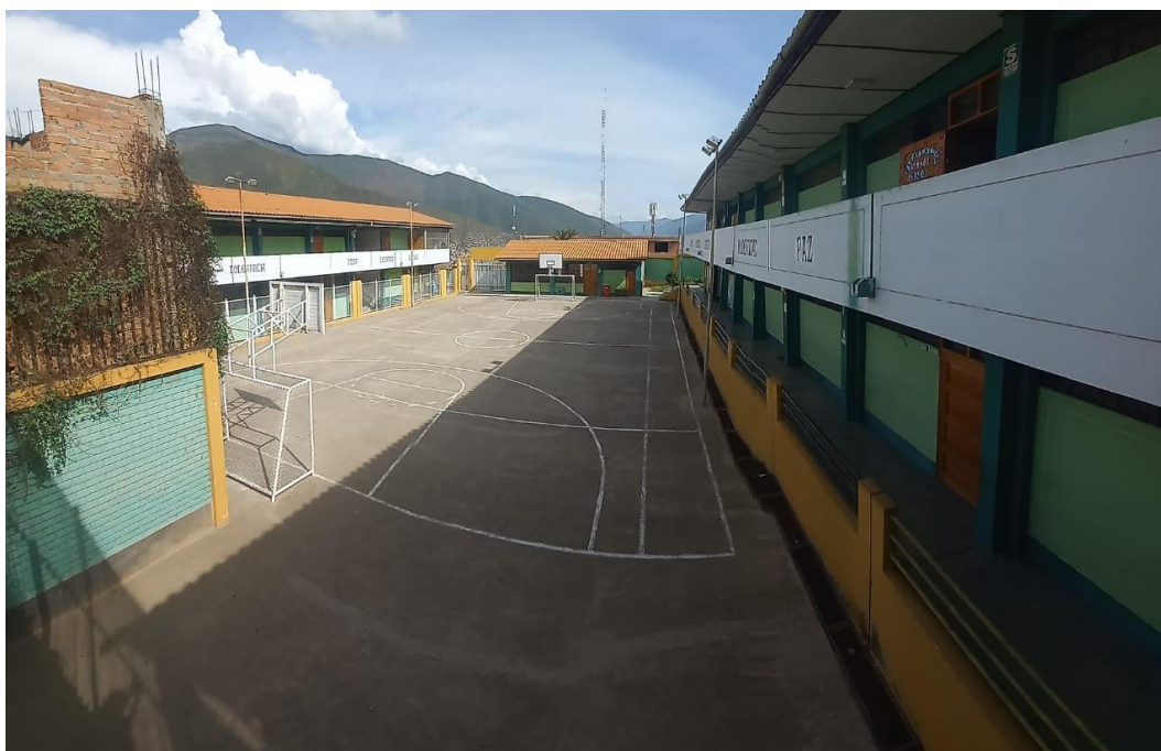
Vista interna de la infraestructura de la I.E.N° 33023 de Loma Blanca
