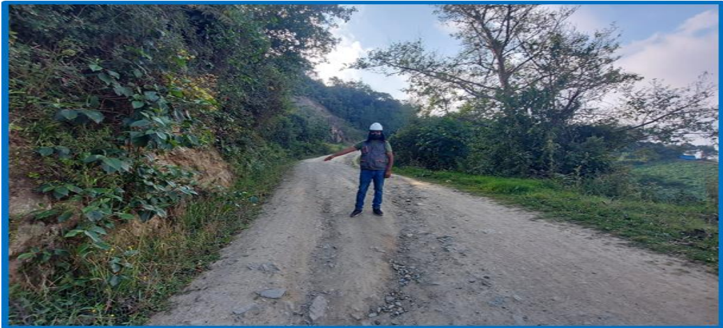
Foto 1. ANTES: Se observa al jefe de mantenimiento en la cuneta con vegetación antes de realizar la actividad de limpieza de cuneta en la carretera en el km 6+100-6+240.
