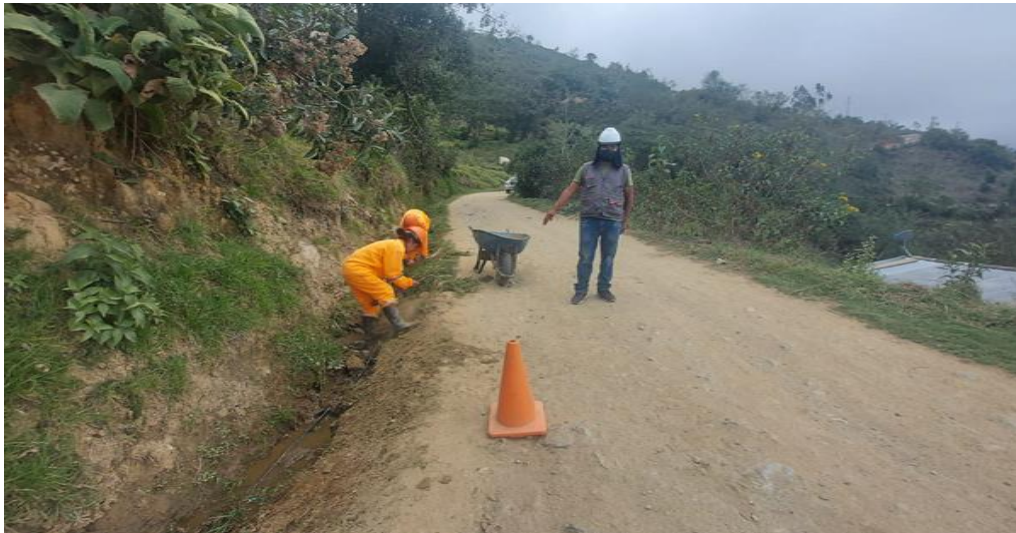
Foto 11. DURANTE: Se observa al jefe de mantenimiento en la ejecución de los trabajos de limpieza de calzada en la carretera del km 1+700 – 1+800.
