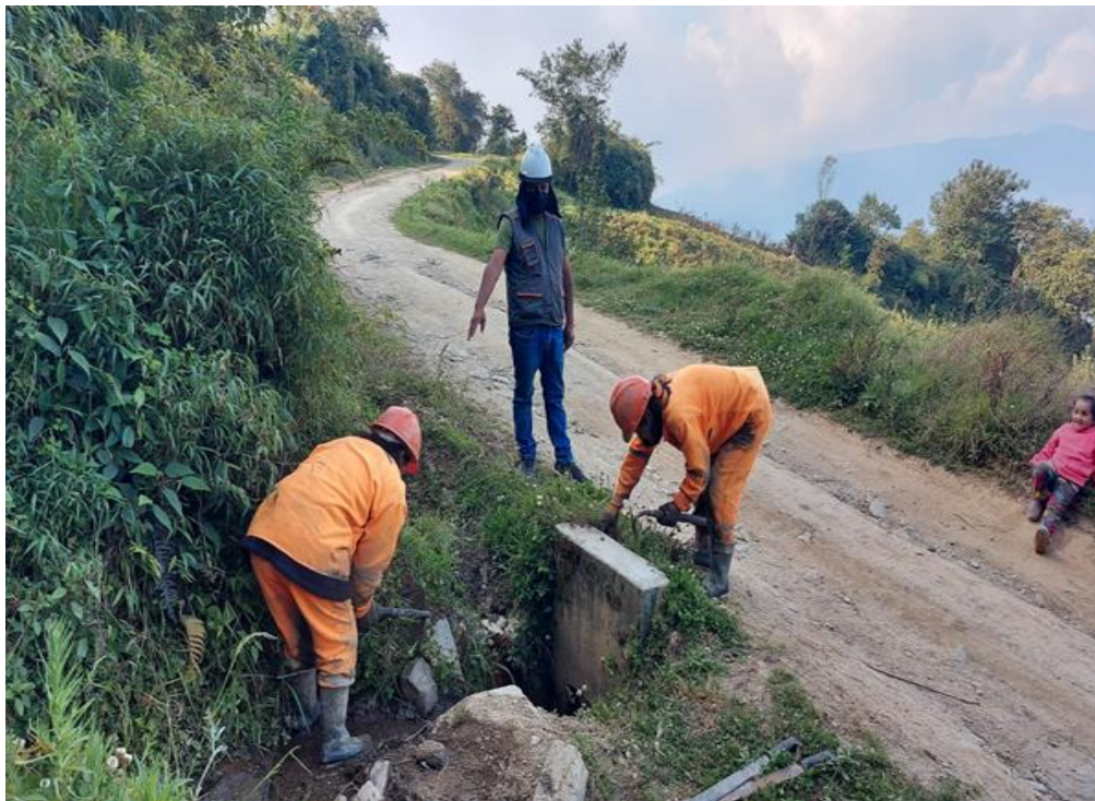
Foto 7. ANTES: Se observa al jefe de mantenimiento en la entrada de la alcantarilla con presencia de vegetación en la carretera en el km 5+639.
