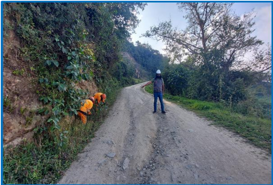
Foto 2. DURANTE: Se observa al personal de servicio de mantenimiento en la ejecución de la actividad de limpieza de cuneta en la carretera del km 6+100- 6+240.
