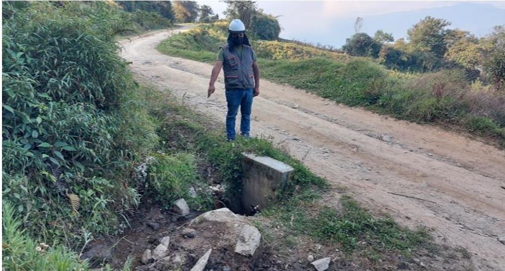
Foto 7. ANTES: Se observa al jefe de mantenimiento en la entrada de la alcantarilla con presencia de vegetación en la carretera en el km 5+639.
