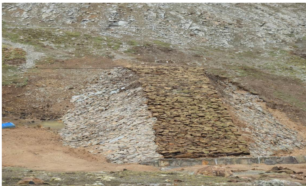
Foto 1 y 2. Reservorios y construcción de los diques en la comunidad de Santa Fé-Paras.
