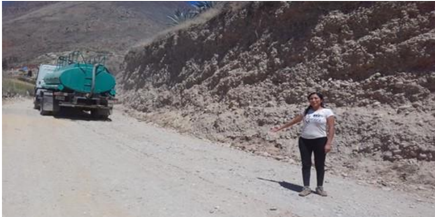
Figura 96 Primero se humedeció el sector y se continuó con el tendido del material acopiado de la cantera
