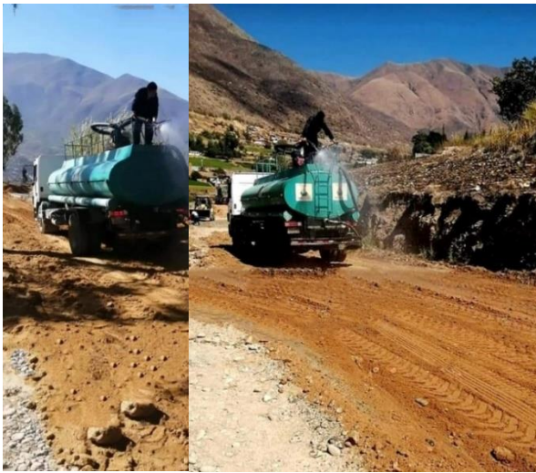
Figura 88 Sistema de tendido de material seleccionado
