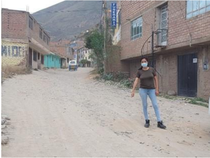
Figura 72 Deterioro en el Sector B
