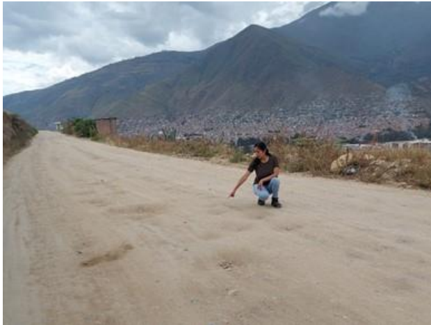
Figura 75 Deterioro superficial de la Carpeta de Rodadura
