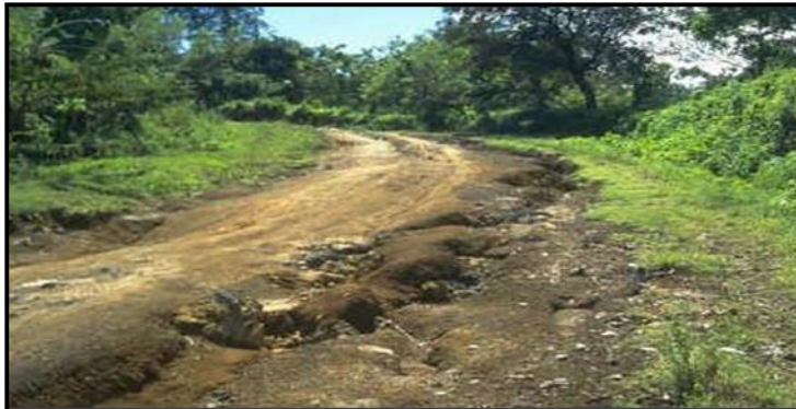
Figura 2 Drenajes inadecuados
