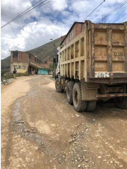
Figura 81 Colocación de Señales de Seguridad
