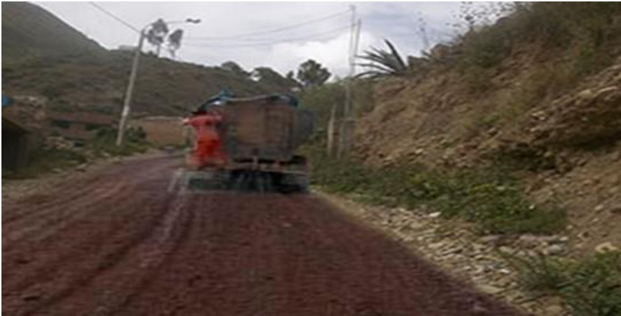
Figura 99 Mezclado y Homogenizado del materia con el estabilizante de suelo (Polyses)
