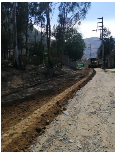
Figura 97 Tendido del material antes de aplicar el estabilizante de suelo (Polyses)
