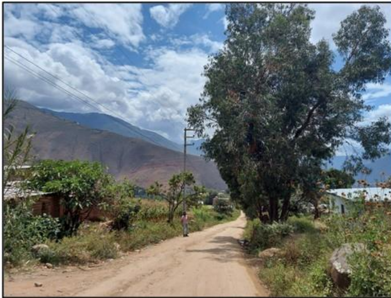
Figura 16 Sector C de la carretera Huánuco - Marabamba
