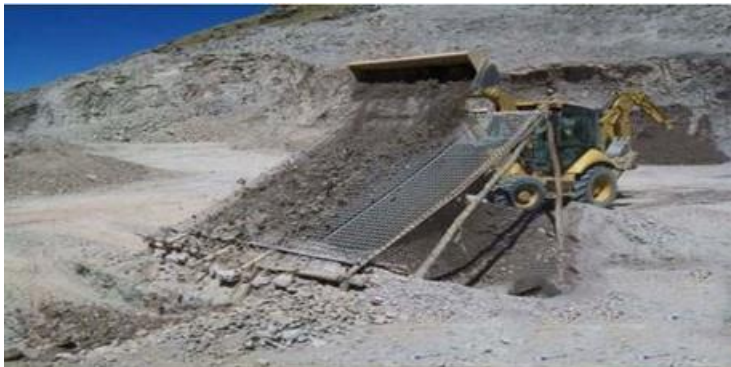
Figura 22 Colocación de zaranda en cantera
