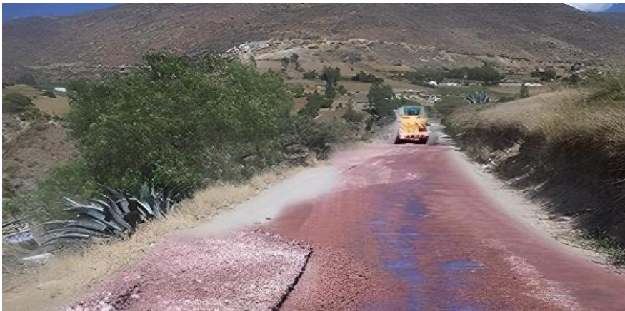
Figura 97 Tendido del material antes de aplicar el estabilizante de suelo (Polyses)
