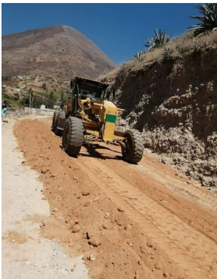
Figura 88 Sistema de tendido de material seleccionado
