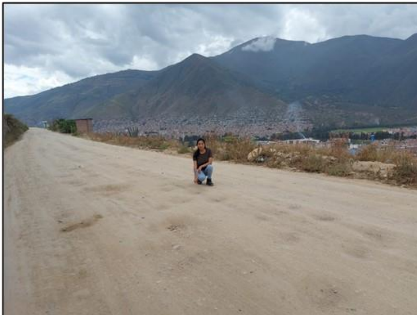
Figura 15 Sector B de la carretera Huánuco - Marabamba
