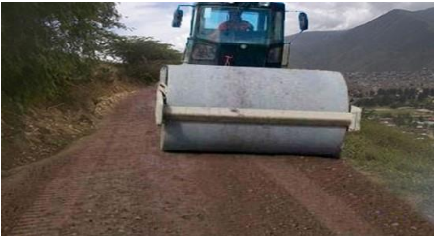
Figura 91 Acabado final después de la aplicación del estabilizante de suelo
