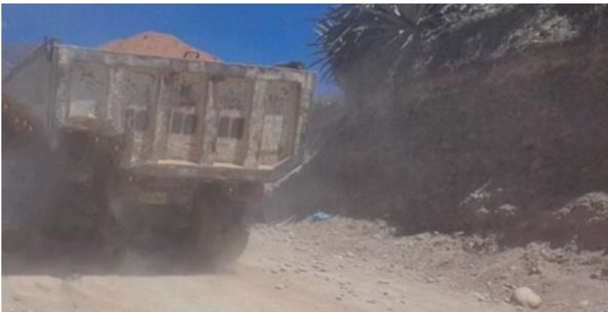
Figura 85 Transporte del material seleccionado para la aplicación con el estabilizante
