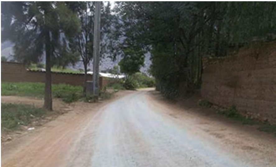
Figura 91 Acabado final después de la aplicación del estabilizante de suelo
