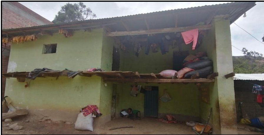
Vivienda ubicada en el centro poblado de Churubamba (Puamba)
