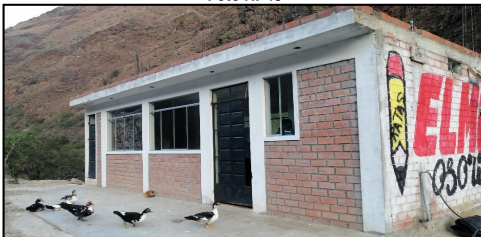
Vivienda ubicado en el centro poblado de Chullqui
