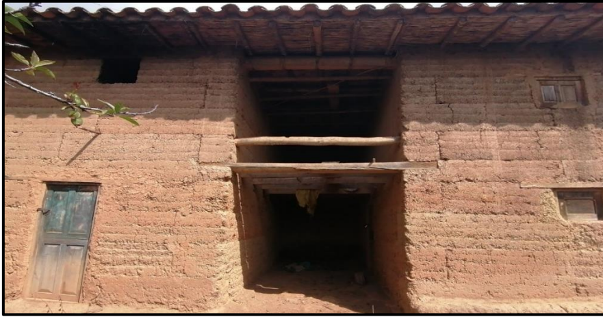
Vivienda ubicado en el caserío de Vinchos
