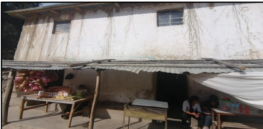
Vivienda ubicado en el centro poblado de Quechualoma (Vilcabamba)
