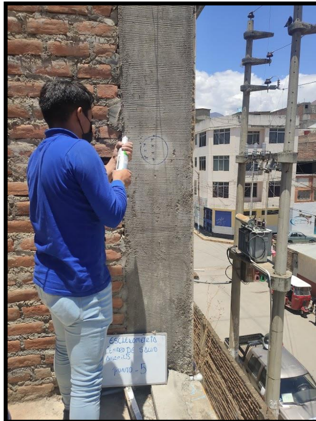
Fotografía 26: Prueba de esclerómetro en columna del tercer nivel del módulo 1.
