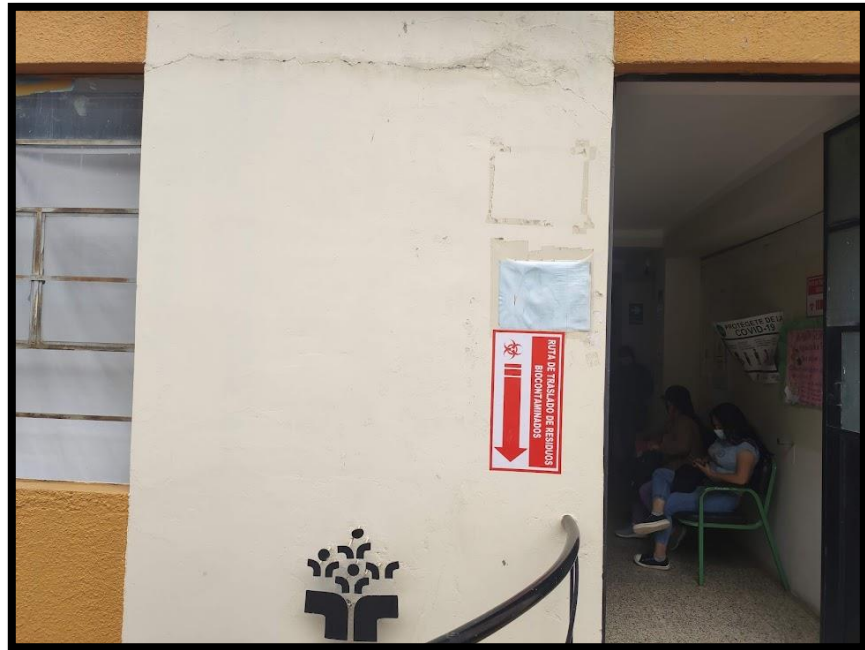
Fotografía 9: Fisuración en muro por dilatación de losa de techo.
