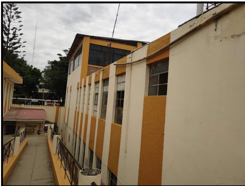
Fotografía 2: Fachada del Módulo 1.
