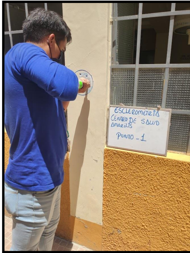
Fotografía 23 y 24: Prueba de esclerómetro en columna primer módulo 1.
