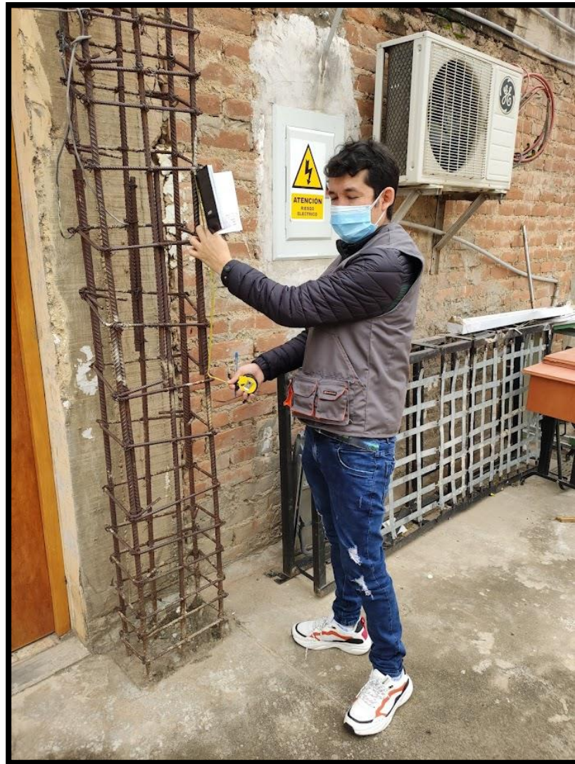
Fotografía 18: Medición de los traslapes en columnas.
