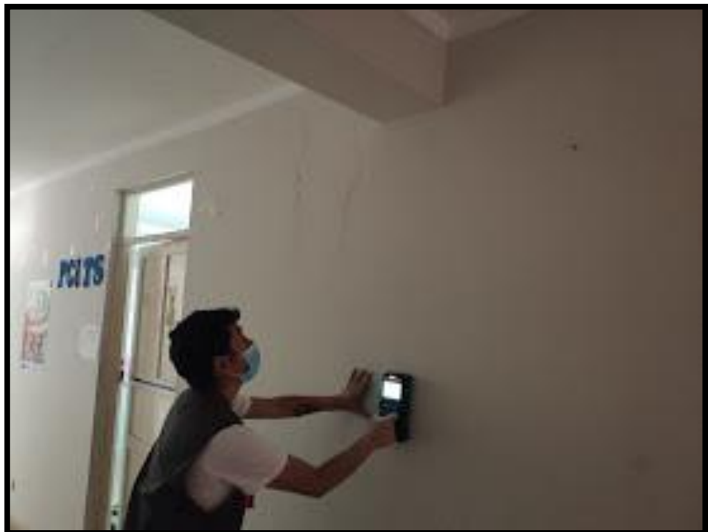
Fotografía 19 y 20: Verificación con GPR en columnas.
