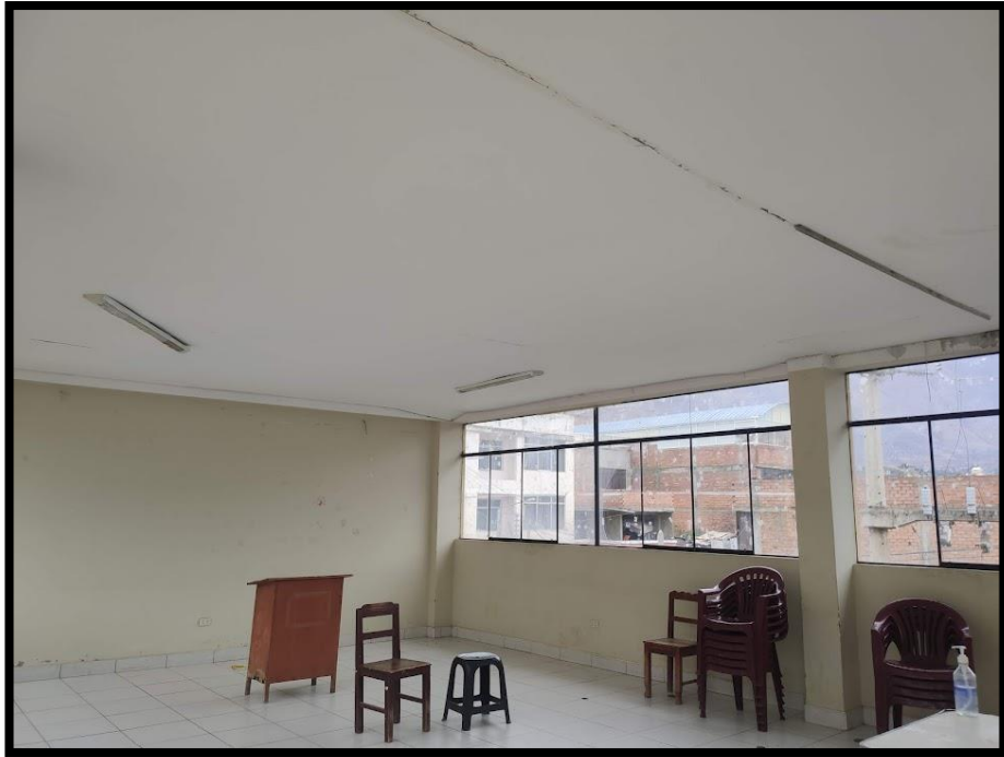
Fotografía 16: Estado actual del tercer nivel del módulo 1, Sala de reuniones.
