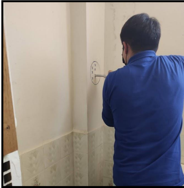
Fotografía 25: Prueba de esclerómetro en columna segundo nivel del módulo 1.
