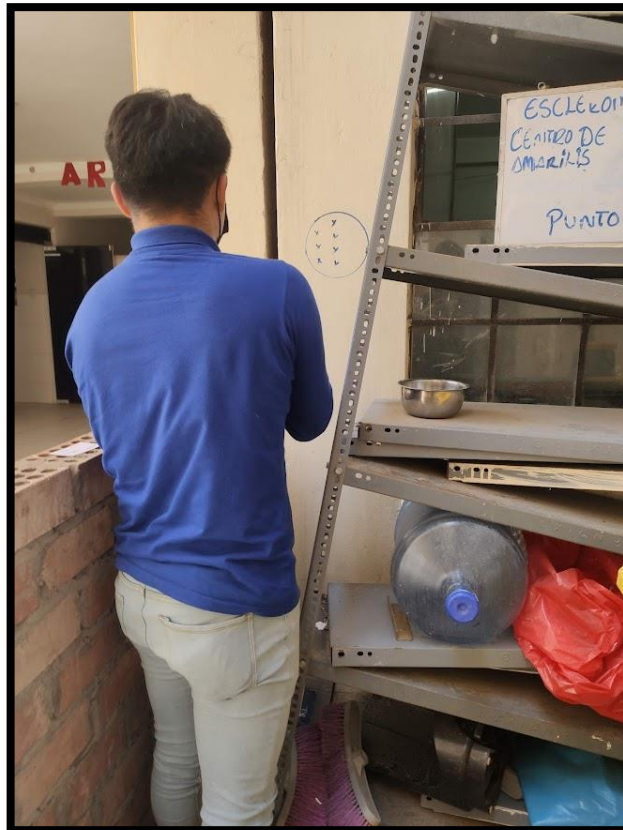
Fotografía 28: Prueba de esclerómetro en columna del primer nivel del módulo 2.
