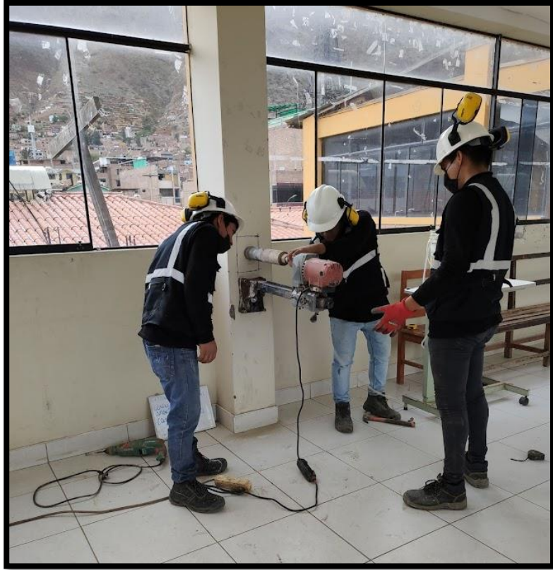
Fotografía 32: Extracción de testigos de concreto.
