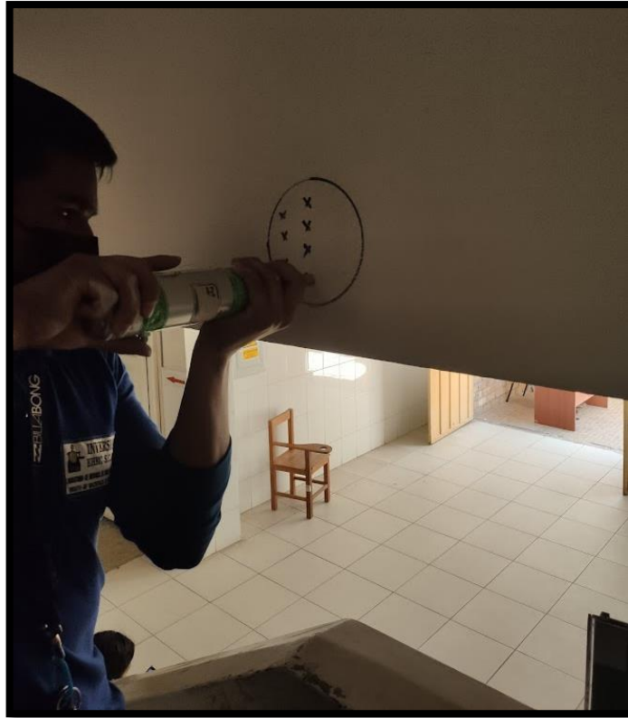
Fotografía 27: Prueba de esclerómetro en viga del primer nivel del módulo 1.
