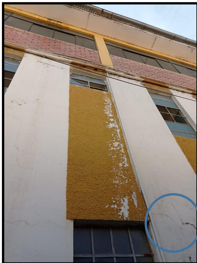
Fotografía 9: Fisuración en muro por dilatación de losa de techo.
