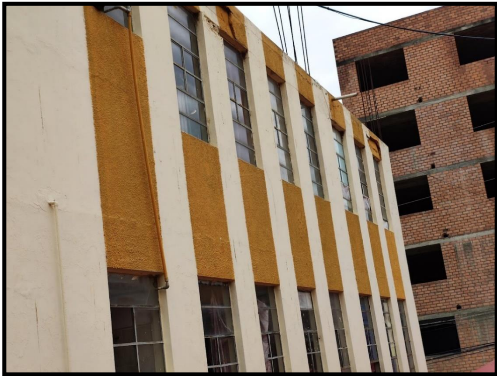
Fotografía 3: Fachada del Módulo 2.
