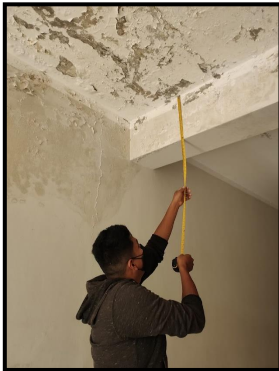
Fotografía 17: Medición de los elementos estructurales, vigas.
