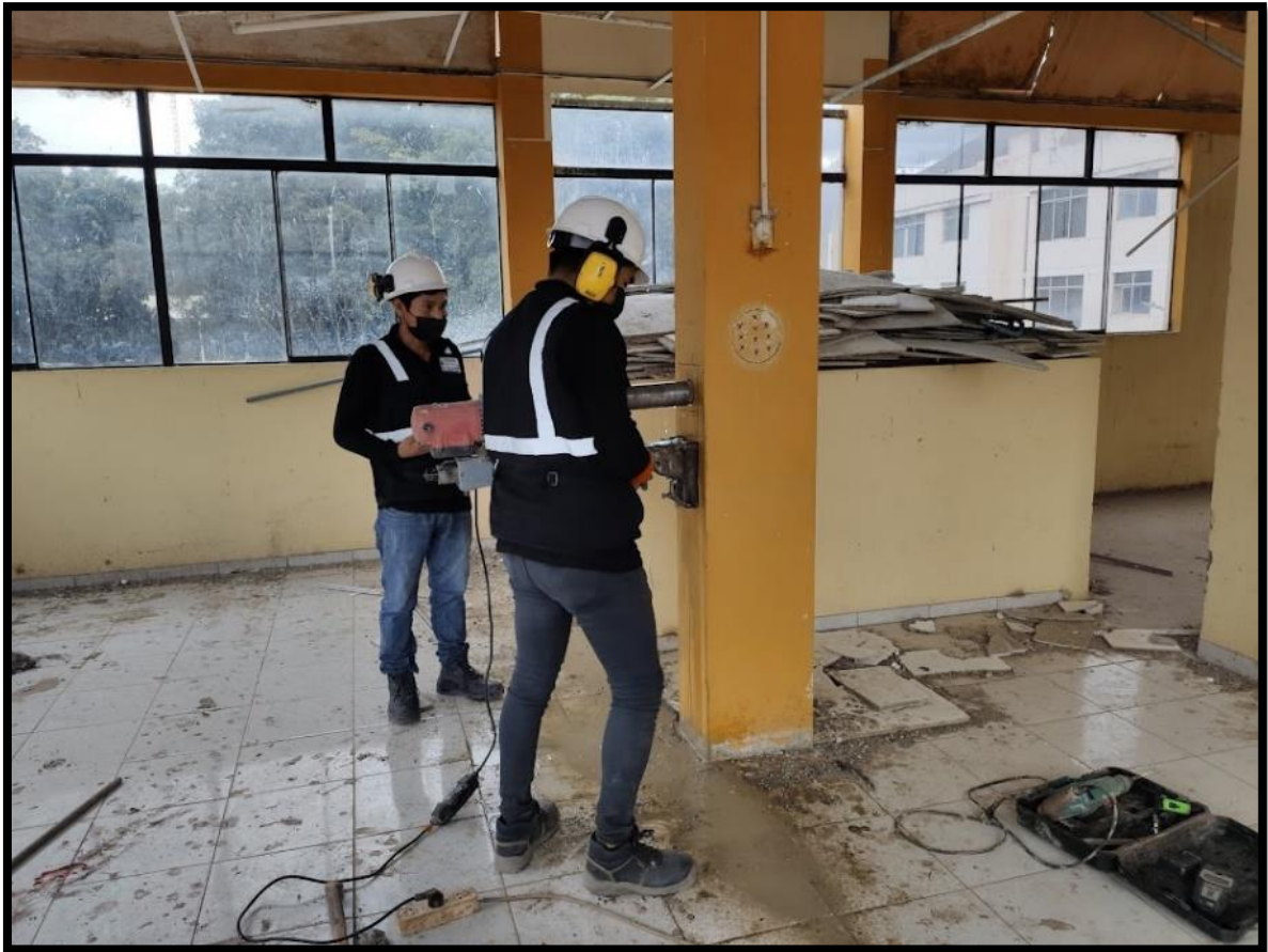
Fotografía 31: Extracción de testigos de concreto tercer nivel (autoconstrucción).
