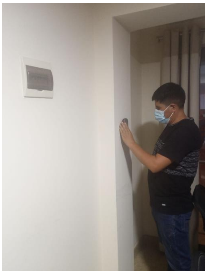
Fotografía 23: Medición con pacómetro en columnas interiores.
