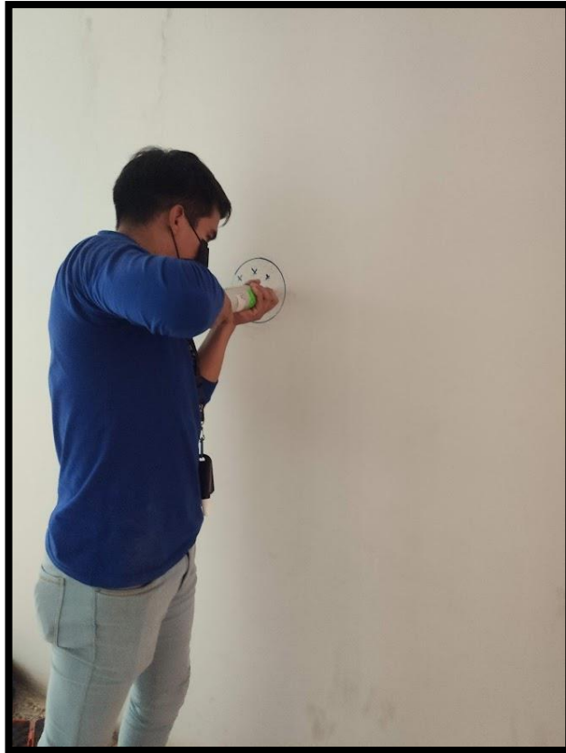
Fotografía 29: Prueba de esclerómetro en columna del segundo nivel del módulo 2.
