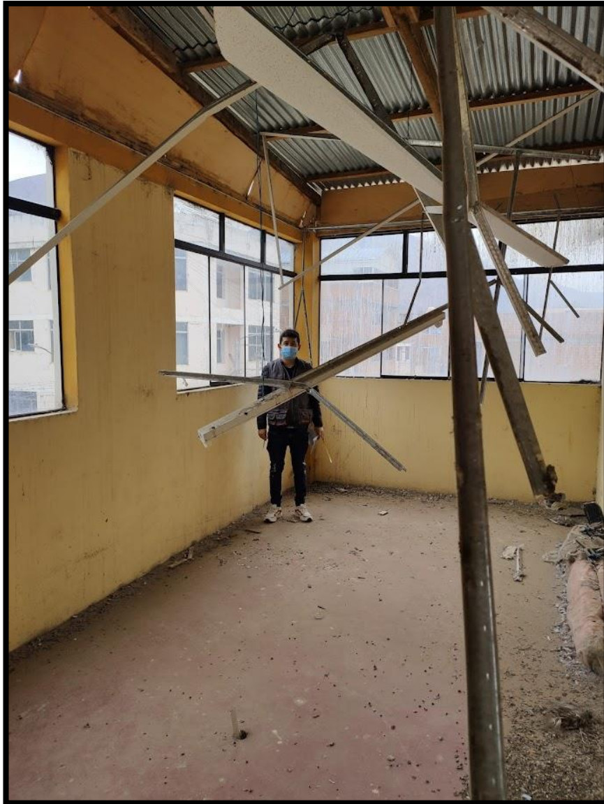
Fotografía 15: Estado actual del tercer nivel del módulo 1.
