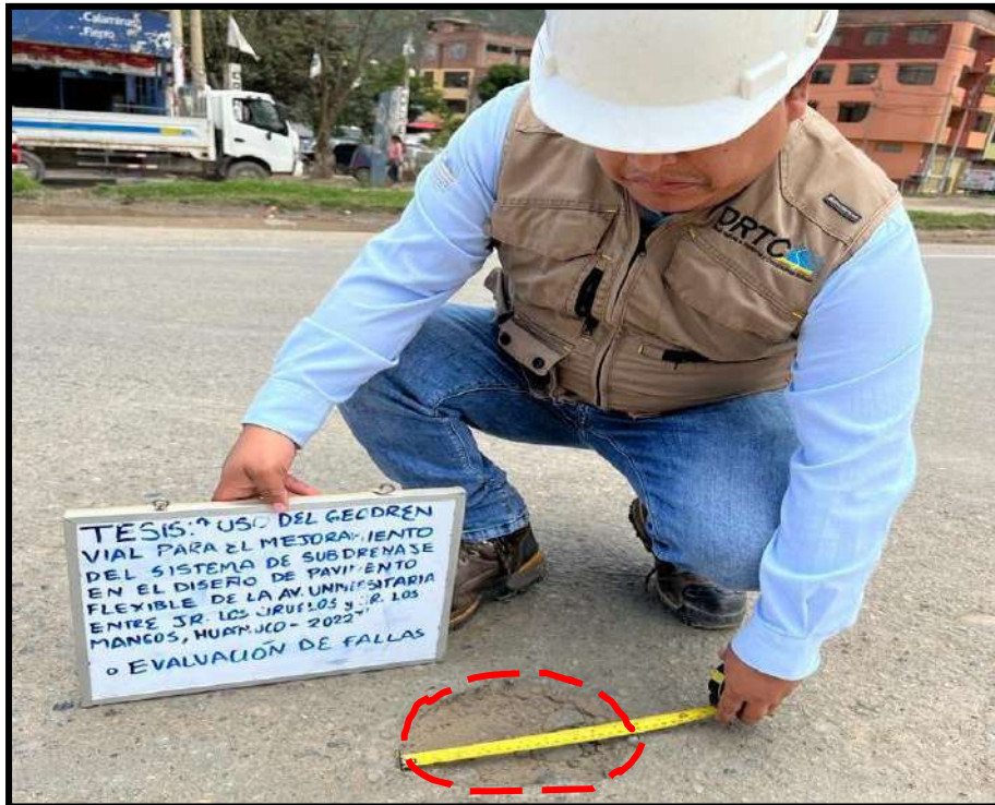
Figura 14 Bache de grado de severidad media , registrado en la unidad de muestra U14, sección 1. Tiene una profundidad de 8 cm y un diámetro de 18 cm.
