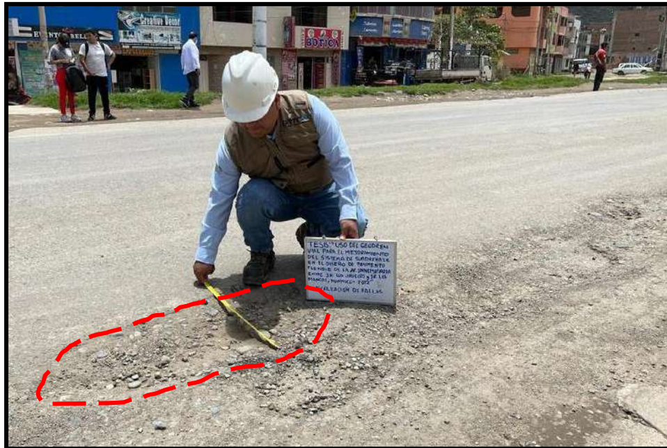
Figura 20 Bache de grado de severidad alto , registrado en la unidad de muestra U20, sección 1. Tiene una profundidad de 8 cm y un diámetro de 77 cm.
