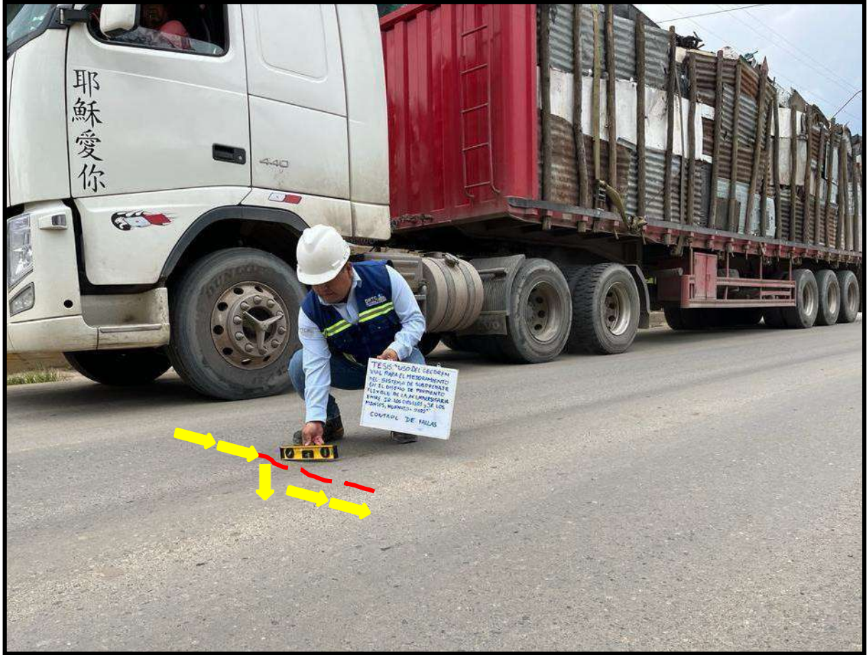
Figura 29 Abultamiento de grado de severidad mediano , registrado en la unidad de muestra U29, sección 1. Tiene una longitud de 87 ml.
