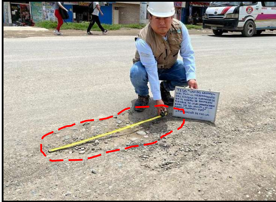
Figura 19 Bache de grado de severidad alto , registrado en la unidad de muestra U19, sección 1. Tiene una profundidad de 12 cm y un diámetro de 87 cm.
