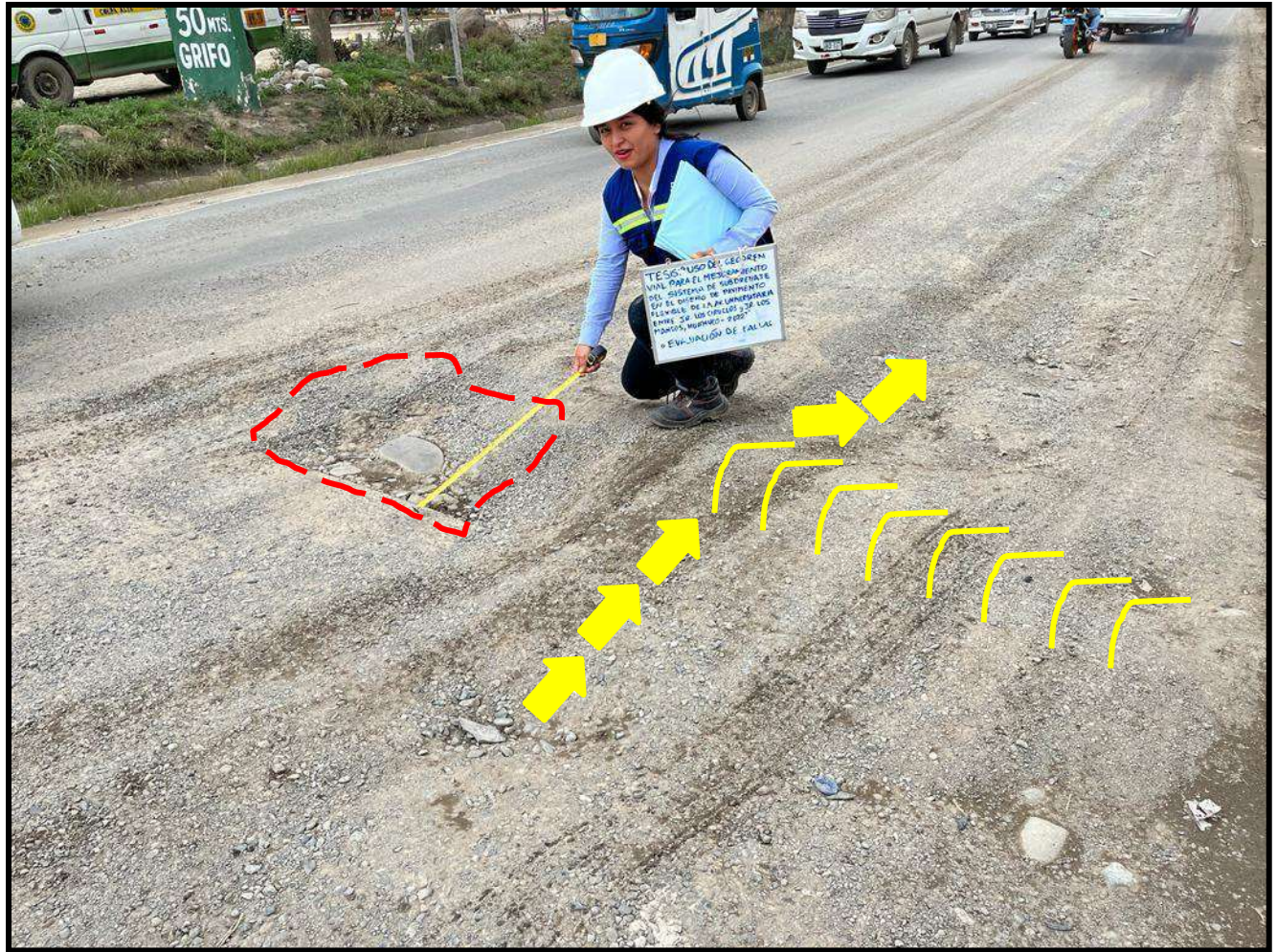
Figura 47 Hinchamiento de grado de severidad alto , registrado en la unidad de muestra U47, sección 1. Tiene una longitud de 3.06 ml.
