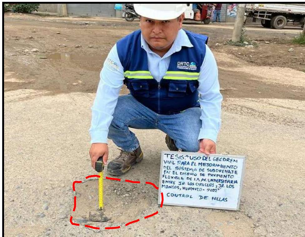
Figura 8 Bache de grado de severidad media , registrado en la unidad de muestra U8, sección 1. Tiene una profundidad de 6 cm y un diámetro de 29 cm.
