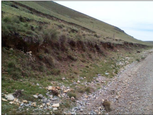
Progresiva 11 + 260km (200m.)
