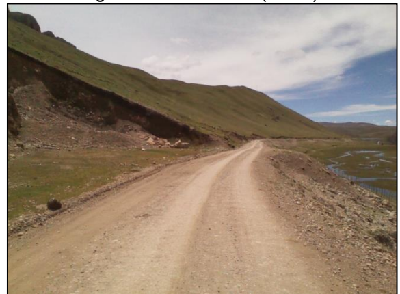
Progresiva 14 + 060km (200metros.)
