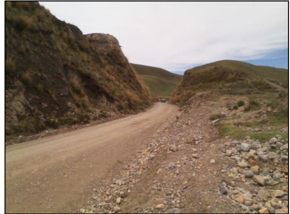
Progresiva 11 + 870km (300m.)
