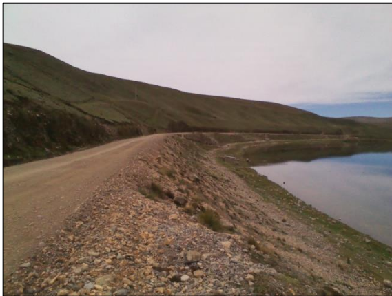
Progresiva 12 + 530km (340m.)
