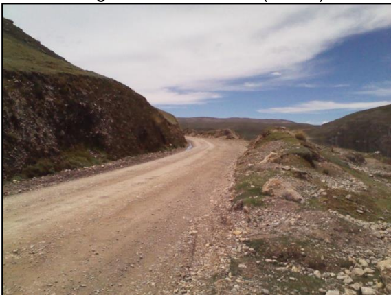
Progresiva 13 + 110km (200metros.)
