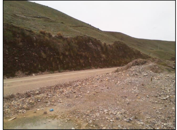
Progresiva 12 + 618km (182m)
