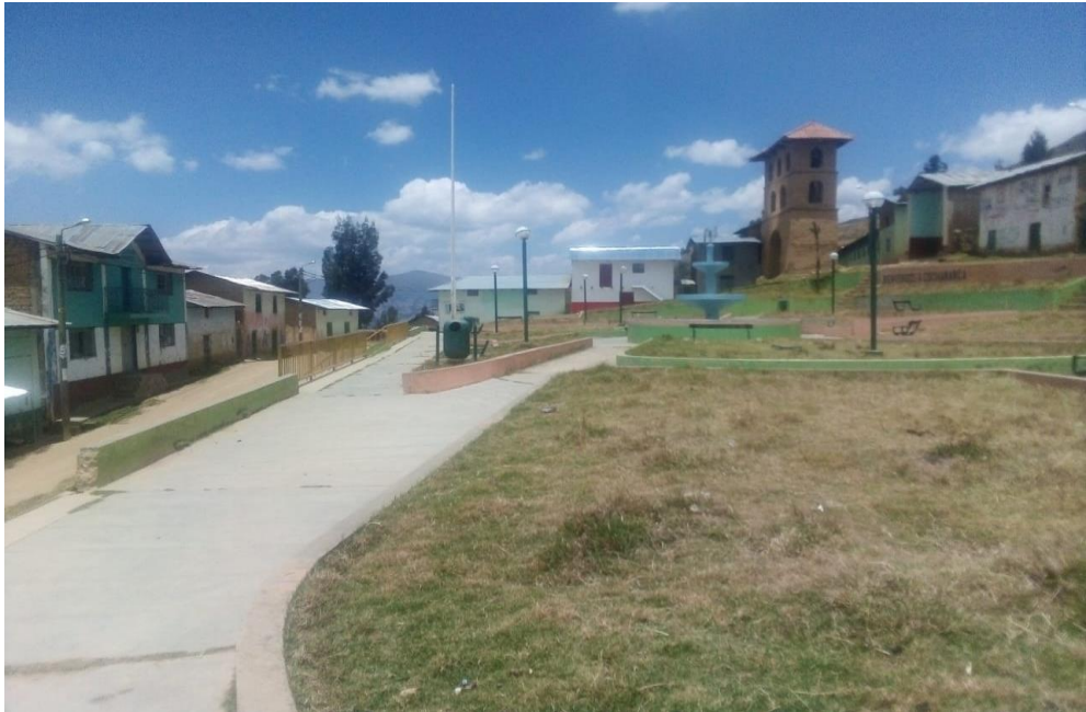
Vista panorámica de la plaza principal de Cochamarca
