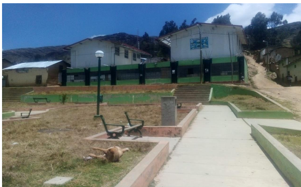
Aulas preconstruidas que albergan a los alumnos del 4to y sexto grado en la I. E. Miguel Grau de Cochamarca.
