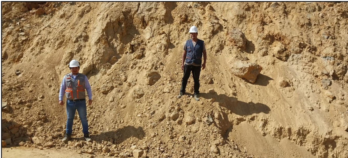
Imagen 05: En la imagen se puede observar a los tesisistas en lugar del deslizamiento de talud en estudio del tramo Rancho-Panao km 42.
