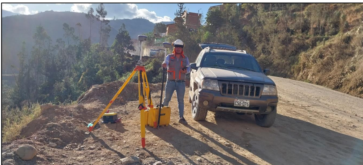
Imagen 04: En la imagen se puede observar el levantamiento topográfico con GPS diferencial de talud en estudio del tramo Rancho-Panao km 42. (Tesisista: JHONATAN DAVID RUIZ HUETE)
