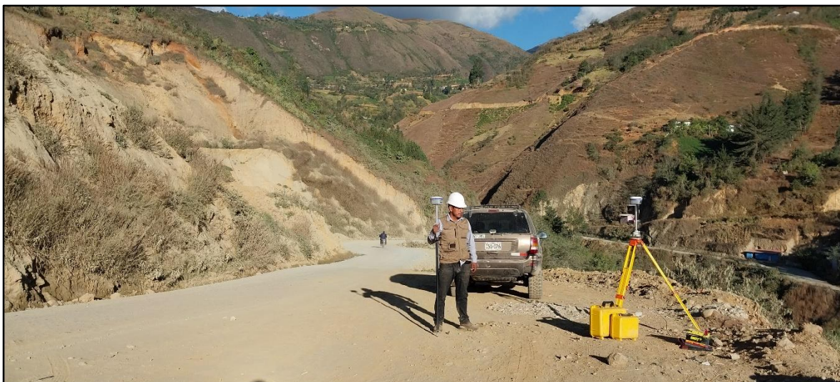
Imagen 03: En la imagen se puede observar el levantamiento topográfico con GPS diferencial de talud en estudio del tramo Rancho-Panao km 42. (Tesisista: ABADIAS ORNETA RETIS)
