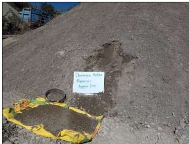
Figura 3. Preparación del agregado fino en cantera.
