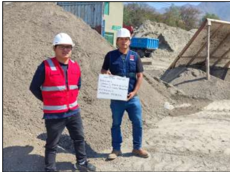
Figura 2. Vista del agregado fino de la cantera.
