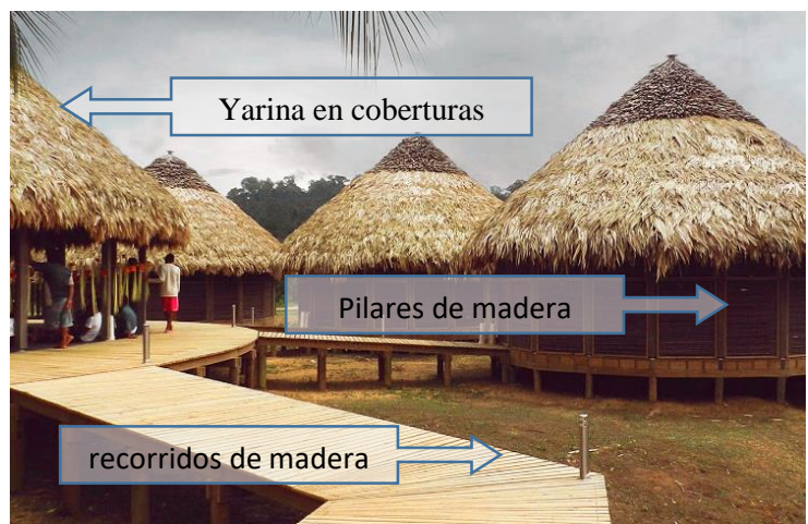
Figura N° 44 Construcción con cobertura en Yarina
