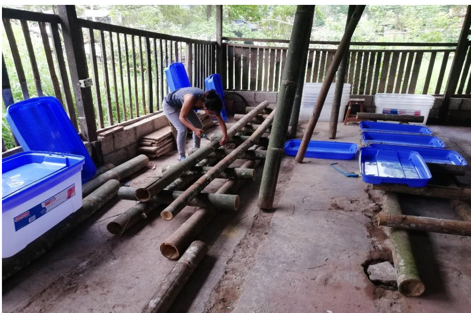
Figura 5. Construcción de los sistemas acuapónicos
