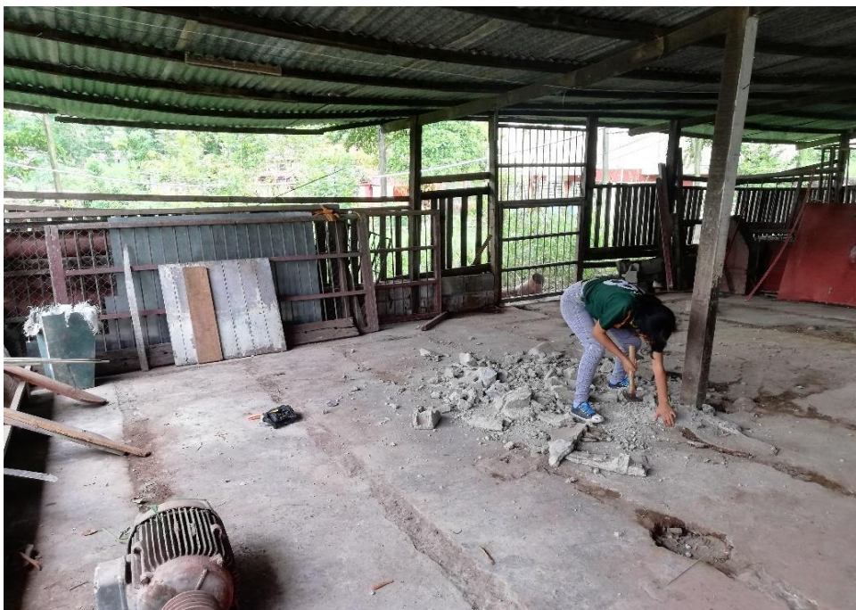
Figura 4. Limpieza del laboratorio para la construcción de los sistemas acuapónicos
