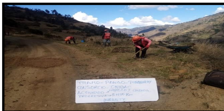
Figura 3. Limpieza de calzada (Durante de las actividades de MVR)
