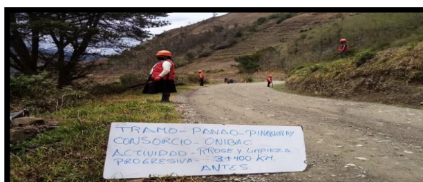
Figura 23. Roce y limpieza (Antes de las actividades de MVR)
