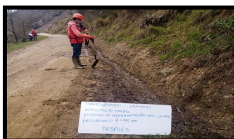
Figura 22. Encauz. De peg. Cursos de agua (Después de las actividades de MVR)
