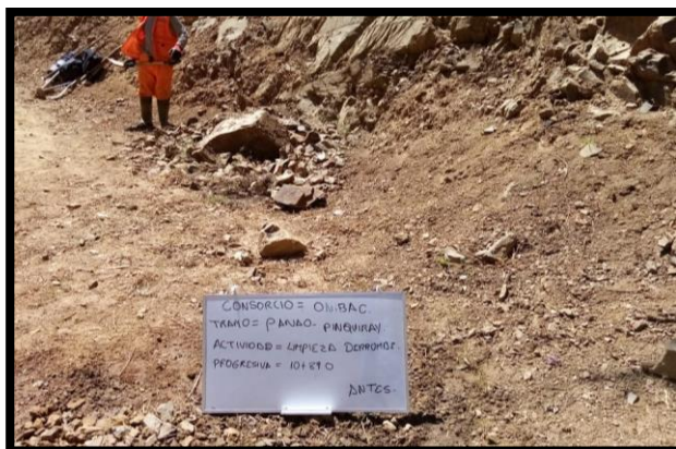
Figura 9. Remoción de derrumbes (Durante las actividades de MVR)
