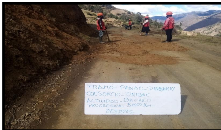
Figura 7. Bacheo (Después de las actividades de MVR)
