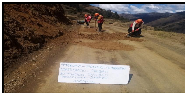
Figura 6. Bacheo (Durante de las actividades de MVR)
