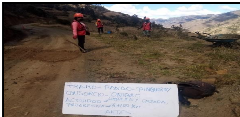
Figura 2. Limpieza de calzada (Antes de las actividades de MVR)
