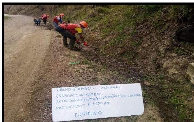
Figura 21. Encauz. De peg. Cursos de agua (Durante de las actividades de MVR)
