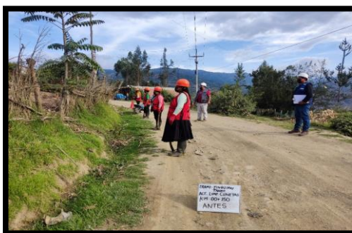
Figura 11. Limpieza de cunetas (Antes de las actividades de MVR)
