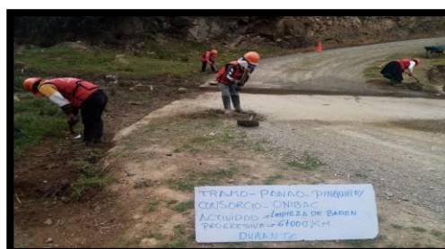
Figura 18. Limpieza de Badén (Durante de las actividades de MVR)
