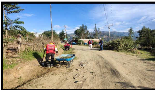
Figura 12. Limpieza de cunetas (Durante de las actividades de MVR)
