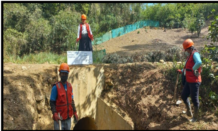
Figura 16. Limpieza de alcantarillas (Después de las actividades de MVR)
