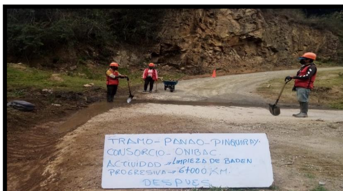
Figura 19. Limpieza de Badén (Después de las actividades de MVR)
