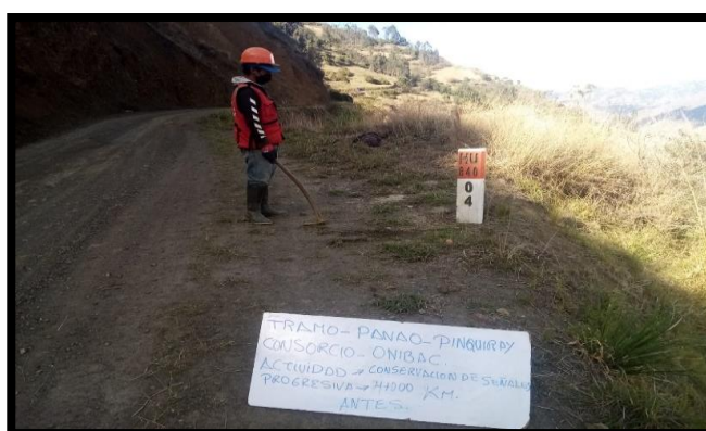
Figura 26. Conservación de señales (Antes de las actividades de MVR)
