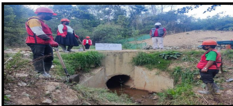
Figura 14. Limpieza de alcantarillas (Antes de las actividades de MVR)
