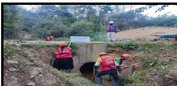
Figura 15. Limpieza de alcantarillas (Durante de las actividades de MVR)
