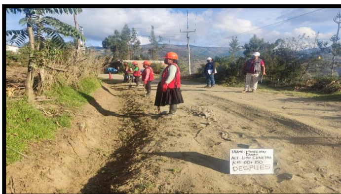
Figura 13. Limpieza de cunetas (Después de las actividades de MVR)
