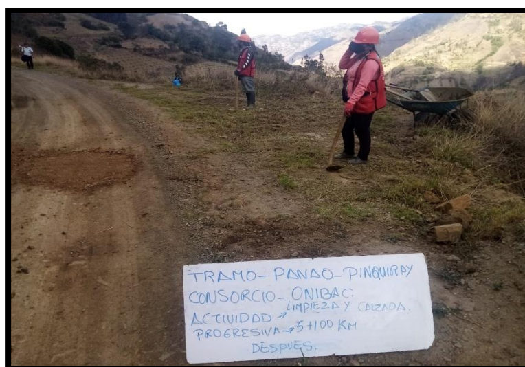
Figura 4 . Limpieza de calzada (Después de las actividades de MVR)
