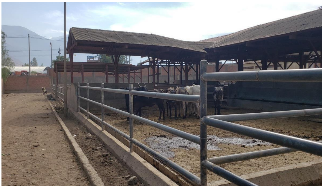
Fotografía 1 Instalaciones del matadero municipal
