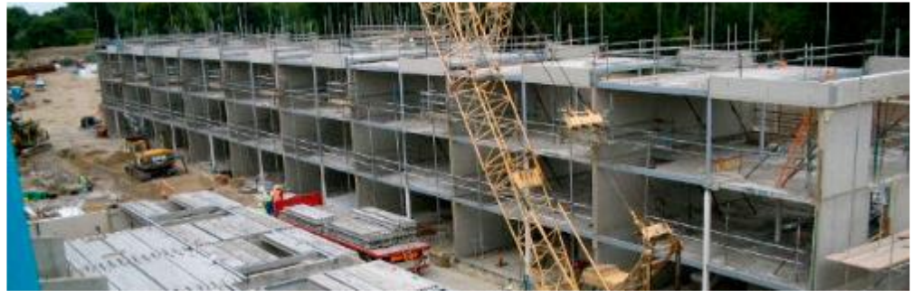
Figura 6 Aulas con sistema postensado
