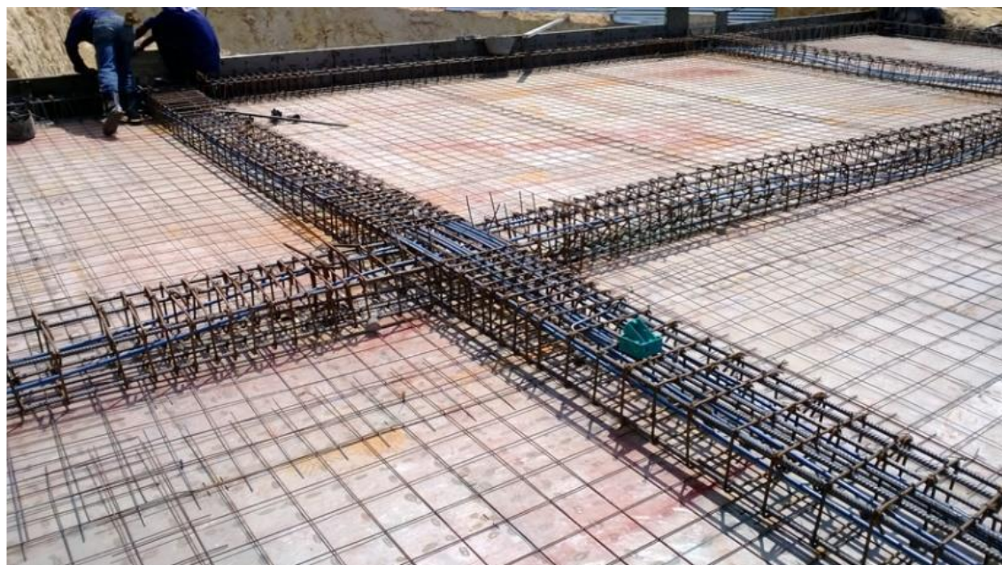
Figura 17 Disposición de cables en las vigas
