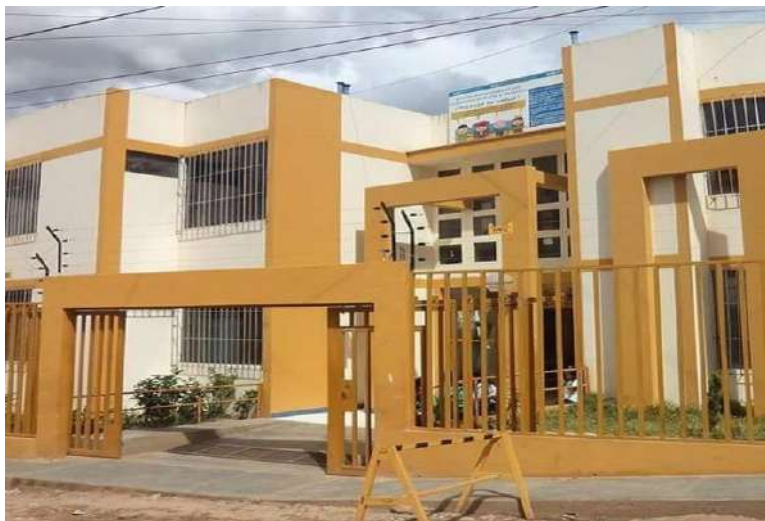
Imagen N° 9: Vista Frontal derecha- zona nueva construida por PARSALUD; Fuente: Di Liberto Moreno (2016); pág. 05
