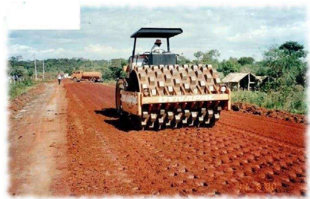
Figura 5. Estabilizacion mecánica campo
