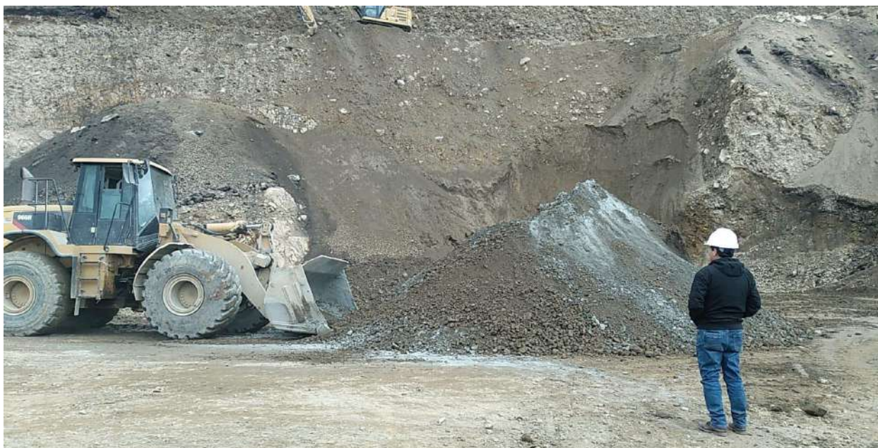
Figura 6. Estabilización en campo tramo Purupampa – Tunapuco – Huascapampa, provincia Pachitea, Huánuco.
