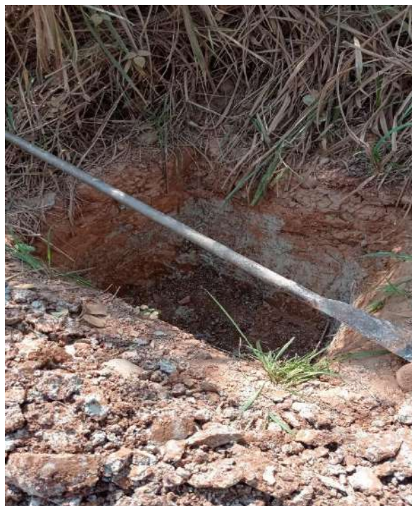
Figura 20. Ubicación de las calicatas
