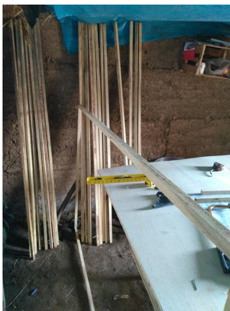
Figura N° 31: Elaboración de Carpintería para la estructuras de Stipa Ichu .
