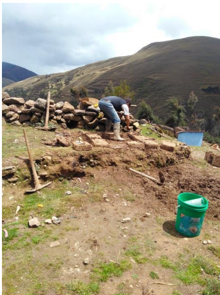
Figura N° 23: Asentado de unidades de adobe.
