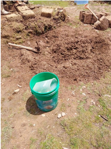
Figura N° 19: Preparación de la tierra. Fuente: Toma fotográfica propia
