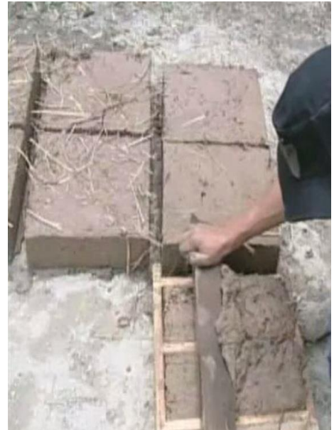
Figura N° 21: Moldeo de las unidades de adobe.
