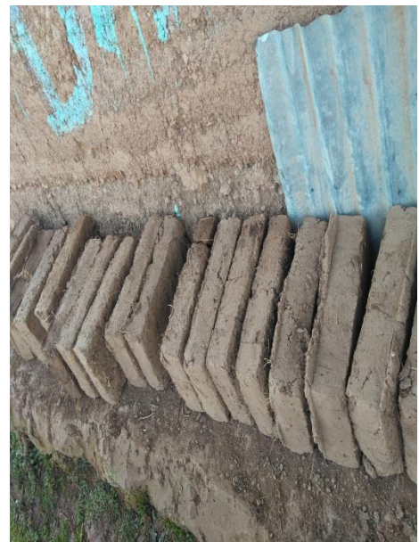
Figura N° 22: Secado de las unidades de adobe.
