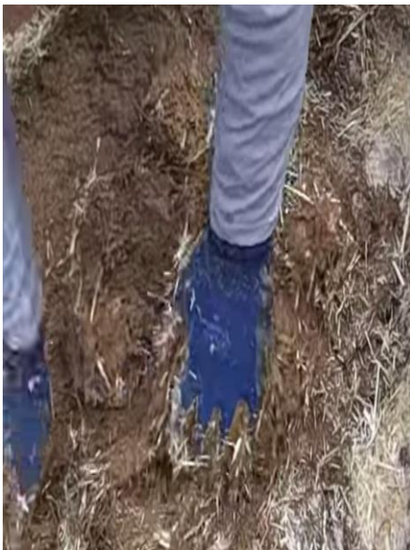
Figura N° 20: Mezclado de las unidades de adobe.
