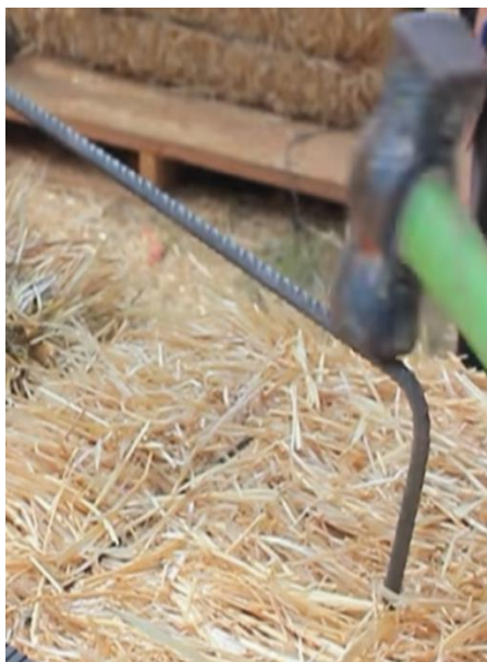
Figura N° 41 Colocado de Varillas de hierro Ø3/8" de L=30cm a @Unión de balas de Stipa Ichu .
