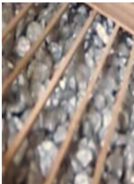
Figura N° 38: Aislamiento del Nivel de piso con piedra y Stipa Ichu .
