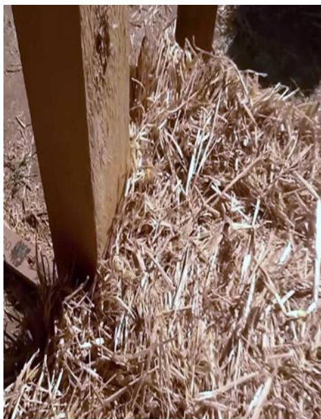
Figura N° 39: Colocado de las balas de Stipa Ichu .
