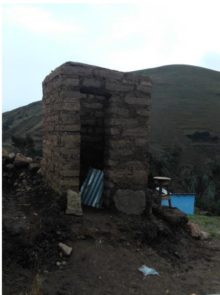
Figura N° 24: Asentado de unidades de adobe.
