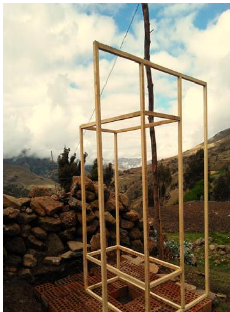
Figura N° 37: Parte del Armado de la estructura de madera con listones de 2"x3" de Stipa Ichu .
