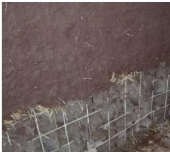
Figura N° 14: Estuco de arcilla colocado sobre malla galvanizada
