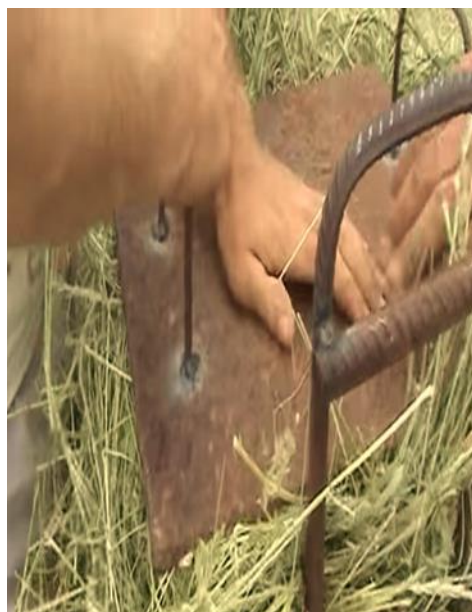
Figura N° 34: Colocado de plancha metálica de 5mm para presionar el Stipa Ichu .
