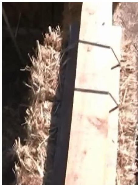
Figura N° 40: Colocado de viga collarín de madera para unión con Stipa Ichu .
