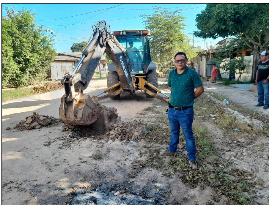
Figura 1. Exploración de calicatas
