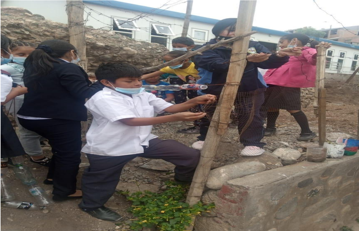
Estudiantes de 4° grado I.E. Santa Rosa Alta se encuentran realizando el cercado de terreno.
