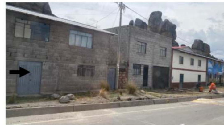
Nota. Adaptada de Viviendas en Canchacucho [Fotografía], por tesistas, 2023.
