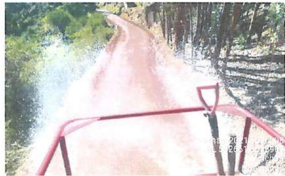
*Estabilización mediante carrotanque y motoniveladora.*
