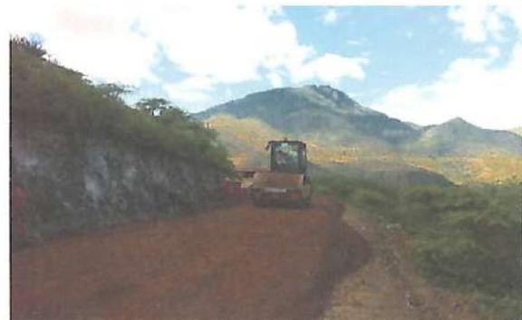
*Precompactación con rodillo vibrocompactador*
