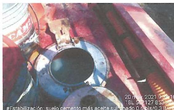
*Mezclado del aceite sulfonado en el carrotanque*
