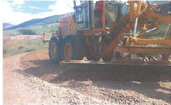
*Perfilado y refino con motoniveladora.*
