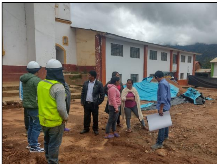
Imagen. - 9. Se evidencia Autoridades Locales en coordinación con el personal técnico sobre las deficiencias encontradas en el expediente técnico, así como también se muestra las gradas de concreto existentes frente a la Iglesia Católica.
