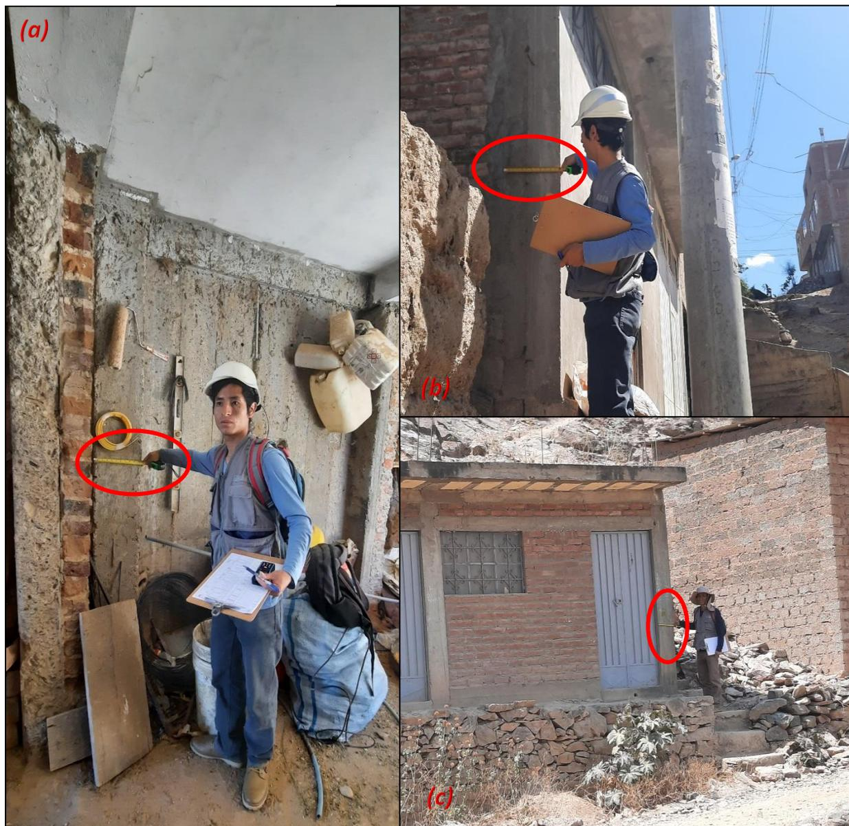
*Nota.* (a) Viviendas con columnas de 30x 30 cm. (b) Columnas de 30x25 cm. (c) Viviendas con columnas de 25x25.
