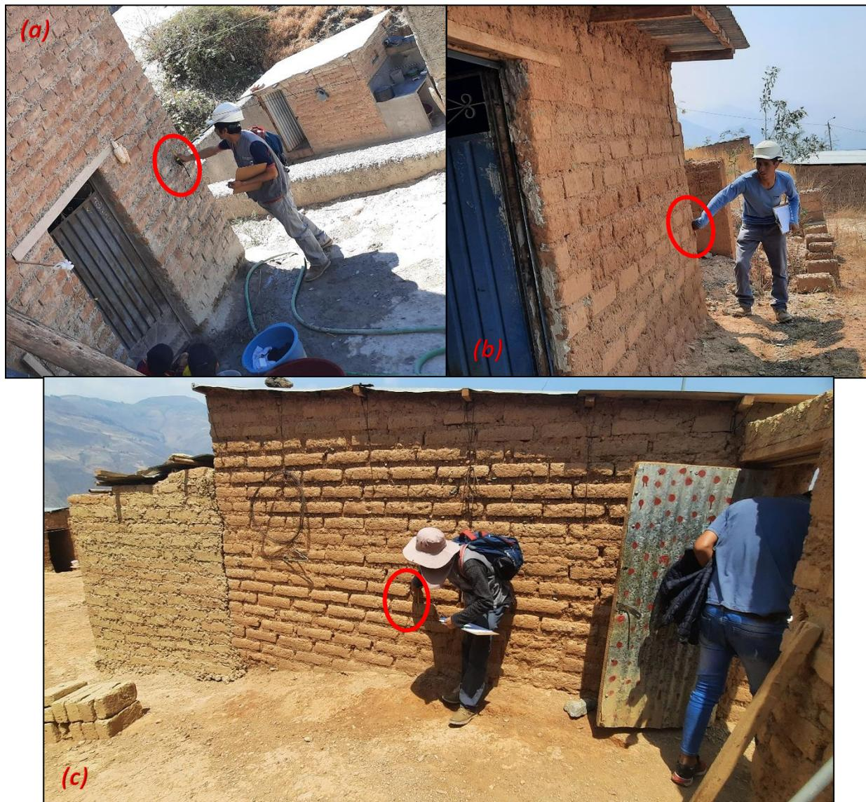
*Nota.* (a, b, c) Adobes asentado solo con barro. Espesores de juntas verticales e hiladas horizontales que varían de 2 cm a 3.5 cm.
