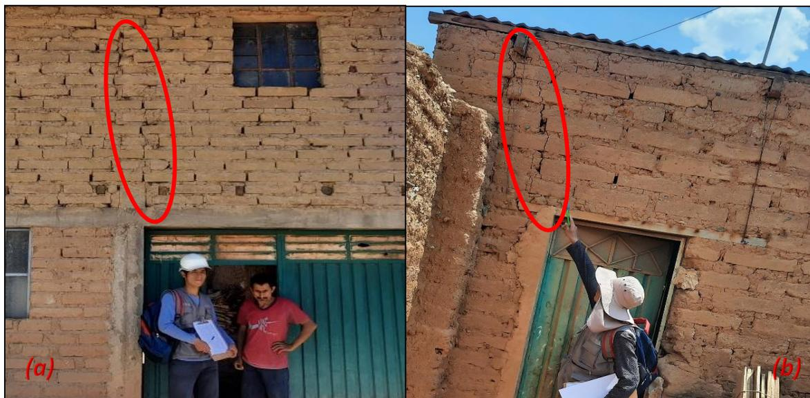
*Nota.* (a, b) Fisuras de muros en viviendas de adobe
