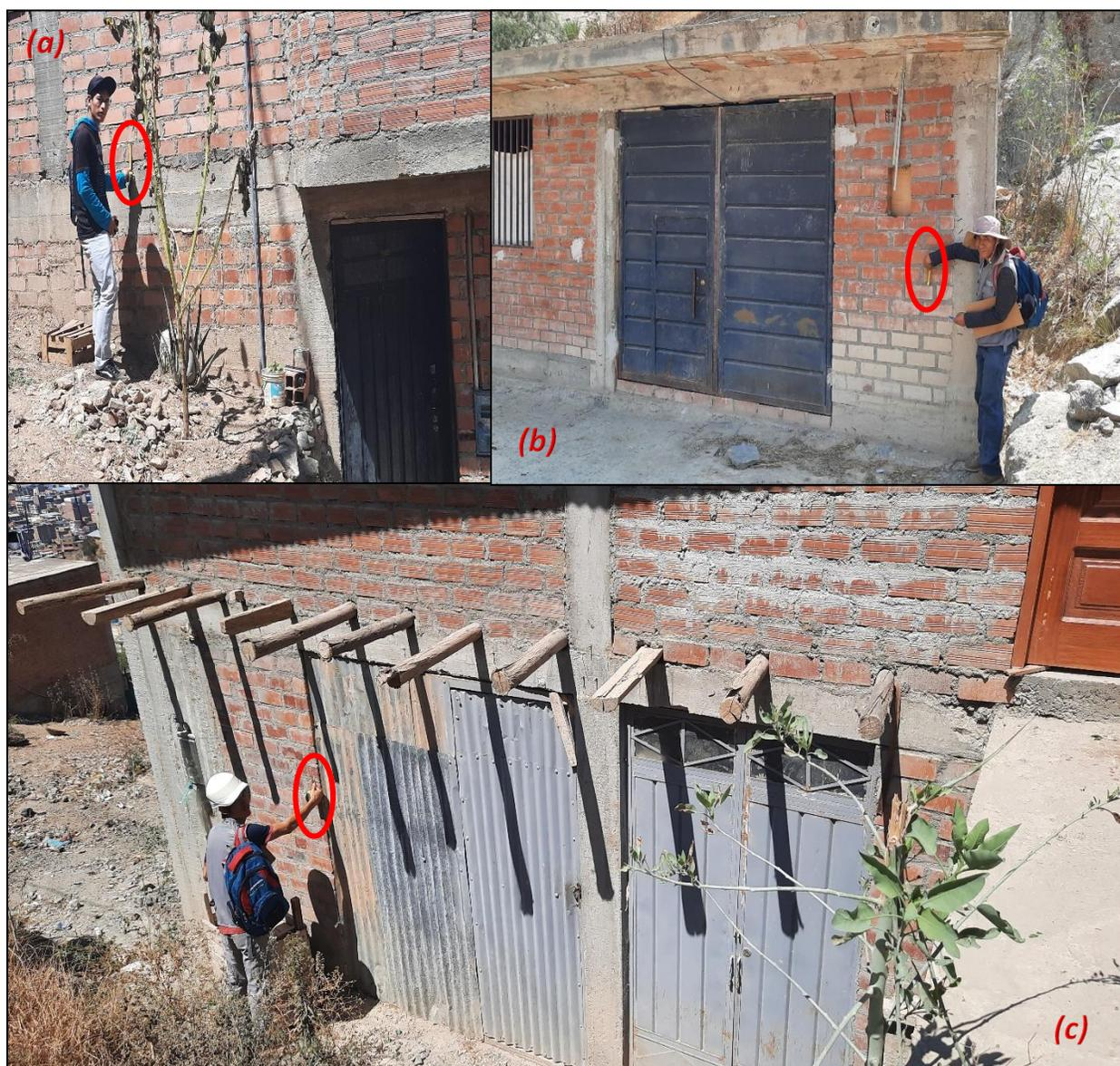
*Nota.* (a) Hiladas de albañilería de 1 cm de espesor con ladrillo 18 huecos. (b) Junta Horizontal de 2 cm en viviendas de albañilería confinada. (c) junta vertical de 2 cm en viviendas de Albañilería.
