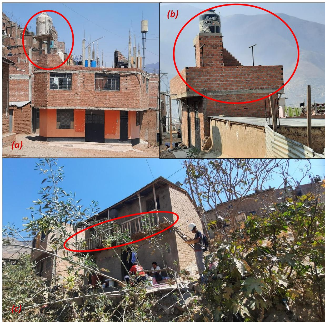
*Nota.* (a, b) Tanques Eternit y parapetos conectados de manera deficiente a las viviendas de albañilería. (c) Balcón de madera con pésima conexión en vivienda de adobes
