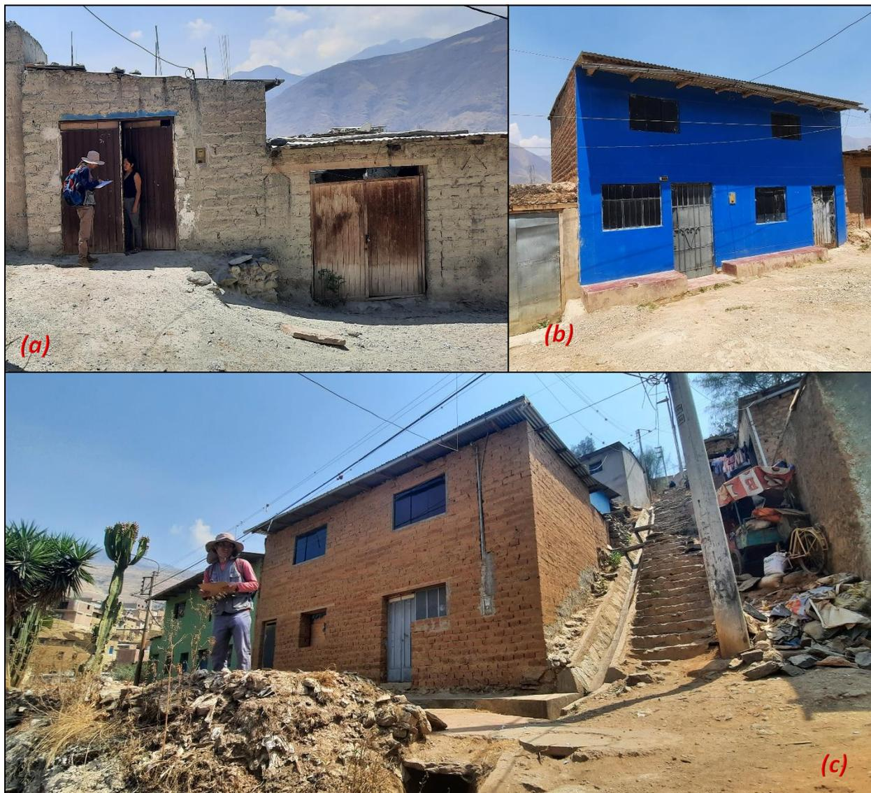
*Nota.* (a) Vivienda de adobe con fisuras y grietas que superan lo 2mm en sus muros. (b) vivienda de adobe en buen estado de conservación. (c) Vivienda en regular estado de conservación.
