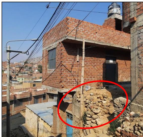
Debilitamiento por modificaciones. - este fenómeno es producto de la falta de un diseño adecuado la cual se pudo observar que algunos propietarios al querer cambiar la distribución de sus viviendas luego de haberlos construido, tienden a dañar los elementos estructurales resistentes como podemos apreciarlo en la figura 36.
