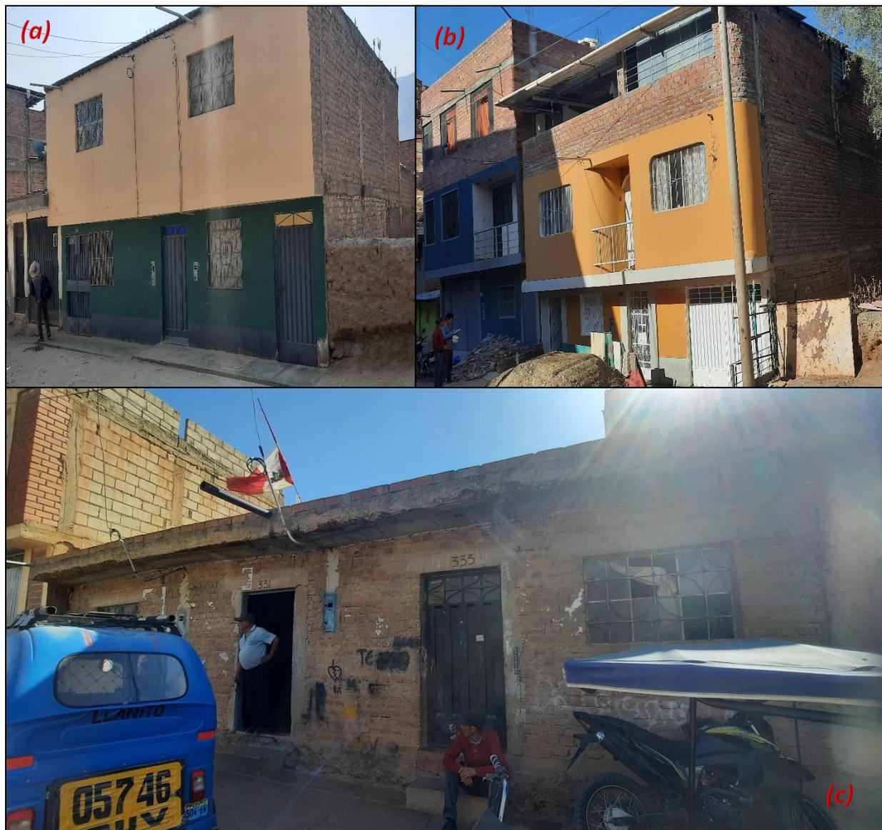
*Nota.* (a) Vivienda de albañilería en regular estado de conservación. (b) Vivienda de albañilería en buen estado de conservación. (c) Vivienda de albañilería en pésimo estado de conservación.
