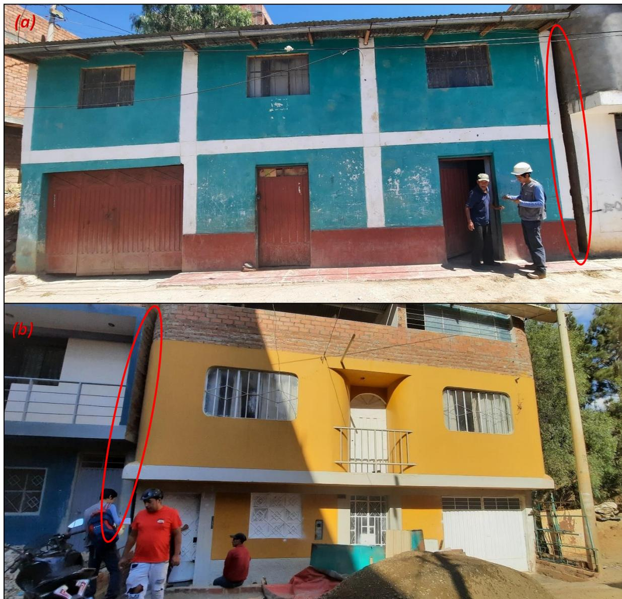
*Nota.* (a) juntas de dilatación acordes a la estructura en viviendas de adobe. (b) Juntas de dilatación acorde a la estructura en viviendas de albañilería.
