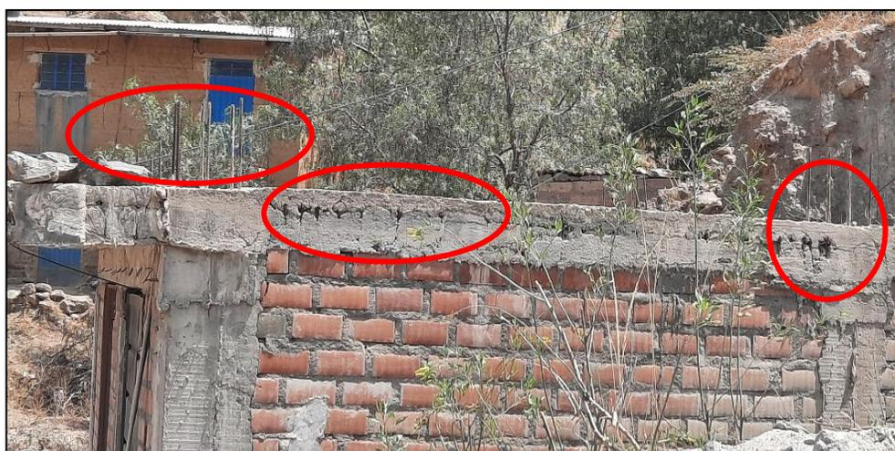
Filtración de techos. - Este daño refleja el deficiente estado en la que se encuentran las cubiertas de las viviendas generalmente de adobe, la cuales permiten el ingreso de las aguas de lluvia que dañan a los muros de las viviendas como podemos observar en la figura 33.
