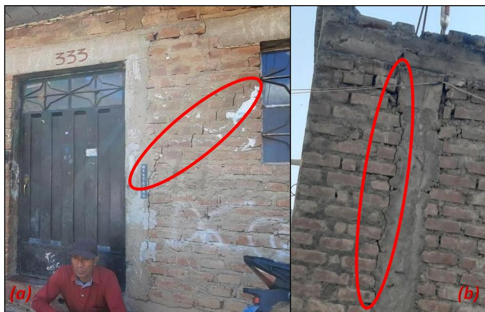
*Nota.* (a, b) Fisuras de muros en viviendas de albañilería.
