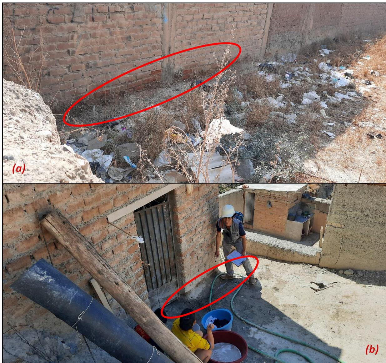
*Nota.* (a) Daño de los muros de albañilería por presencia de humedad. (b) Daño de los muros de adobe por presencia de humedad.
