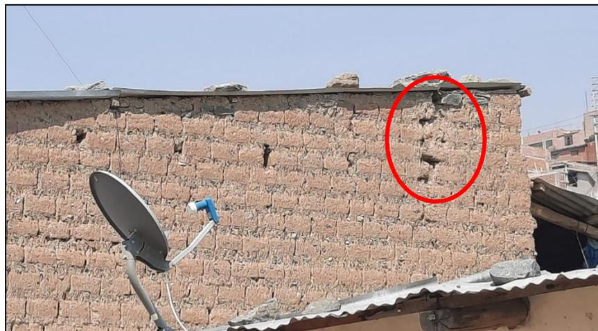
Cargas laterales. - buen porcentaje de las viviendas en general se encuentran en esta situación, la exposición a cargas laterales del suelo debido a las pendientes del área de su construcción y zonas aledañas, como se pueden apreciar en las figuras 34 y 35.
