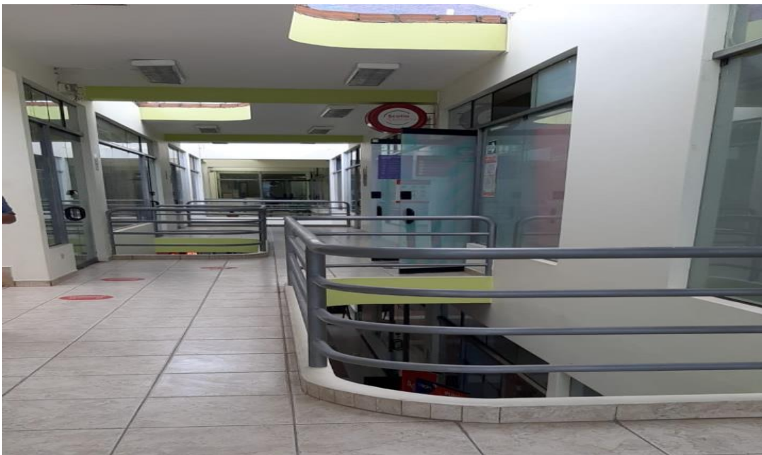
Foto N°02: Tipo de Barandas para su Valuación.
