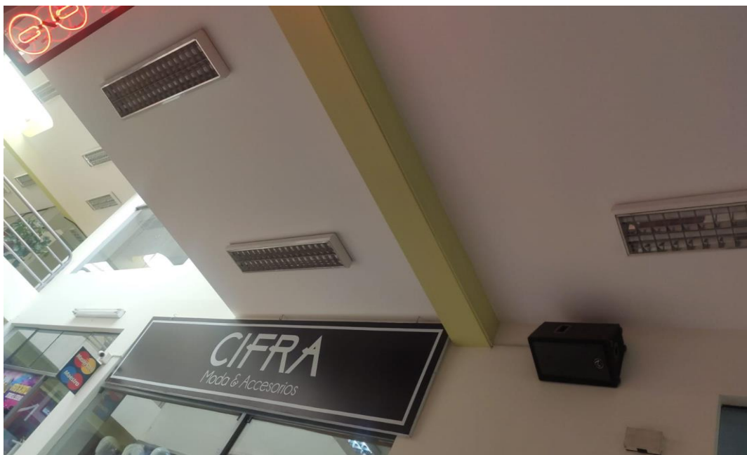
Foto N°10: Cielo Raso del Centro Comercial es de Sistema Porticado para su Valuación.
