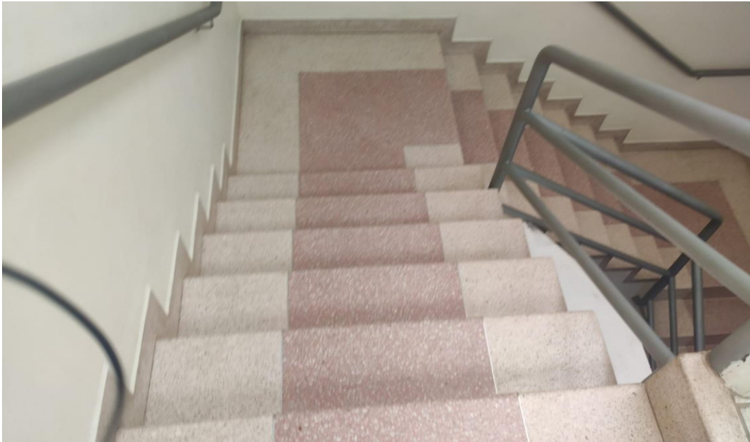
Foto N°03: Acabado en Escaleras para su Valuación.
