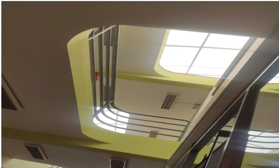
Foto N°08: Circulación Vertical del Centro Comercial es de Sistema Porticado para su Valuación.
