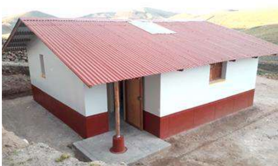
Figura 76. Vista exterior de la construcción de una Sumaq Wasi región Sierra
