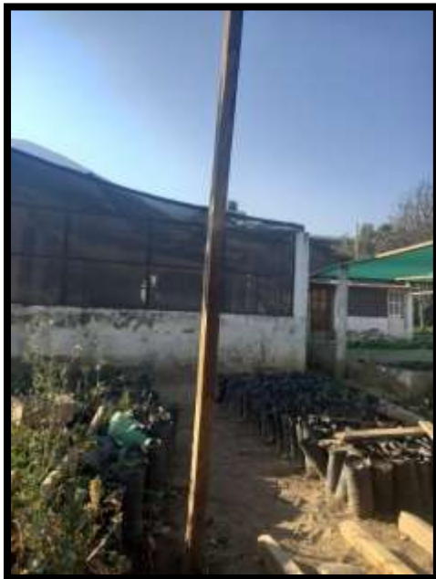
Fig. Construcción del cerco del vivero.
