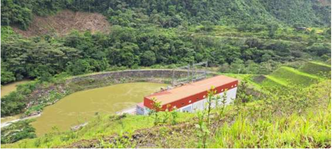
Figura. N° 06 la habitación de generadores de energía
