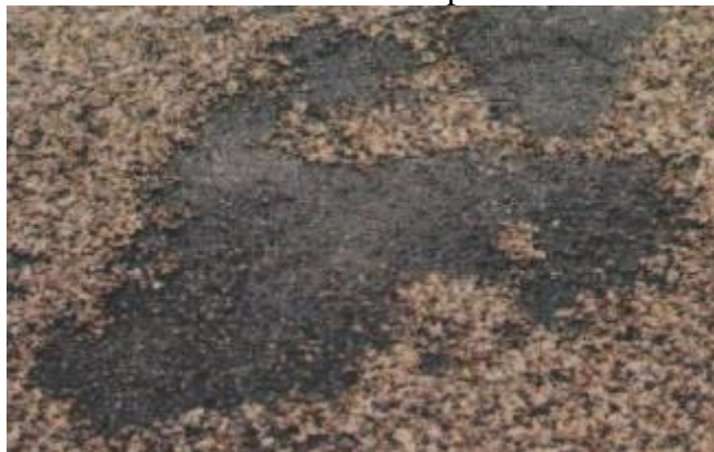
Figura N°7 Gravedad 3: Continuo con aparición de la base granular
