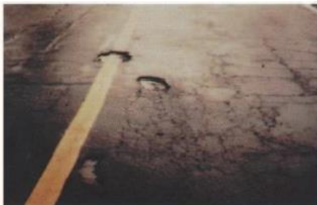
Figura N°8 Gravedad 1: Diámetro < 0.2 m
