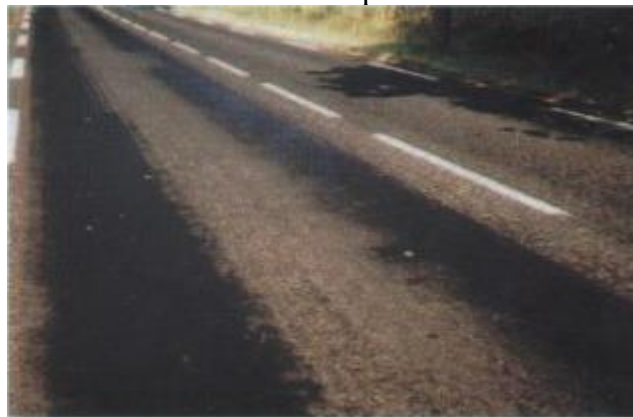
Figura N°10 Gravedad 3: Continua con superficie viscosa
