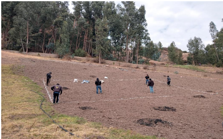
Figura 10. Preparación de terreno
