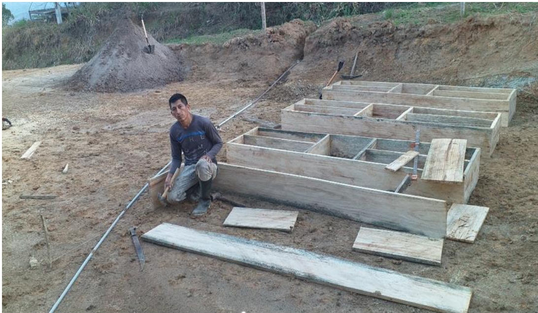
Foto 1. Construcción de la cama de germinación
