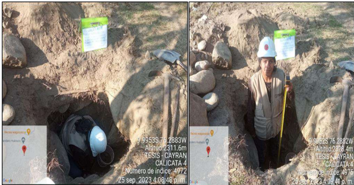
Ilustración 129: Calicata N° 4 FAJA MARGINAL DEL RÍO DEL C.P. RELAVE – Profundidad: 1.50mts. – No Se encontró Nivel Freático – Nos permitirá ver los diferentes estratos para nuestro estudio Granulométrico y poder determinar nuestro
