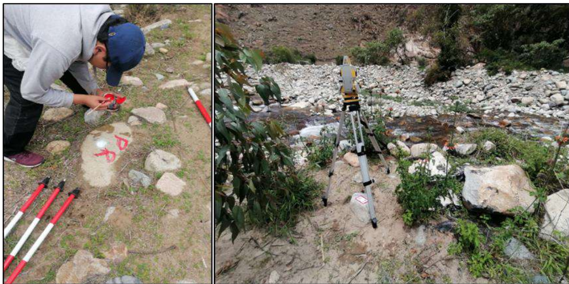
Ilustración 15: Colocación de Puntos Auxiliares
