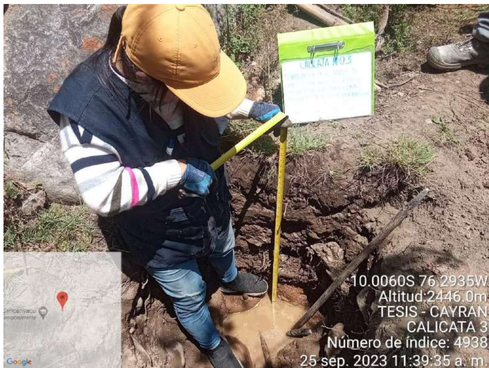
Ilustración 36: Medición de la profundidad de las calicatas.
