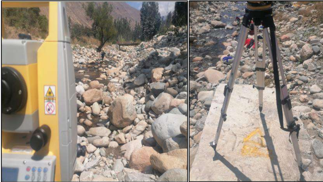
Ilustración 16: Colocacion de BMs
